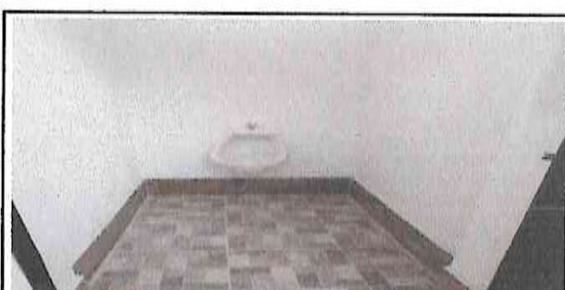
SUSTITUCIÓN DE SANITARIO POR MINGITORIO
