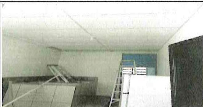
Sustitución de pintura en cocina
