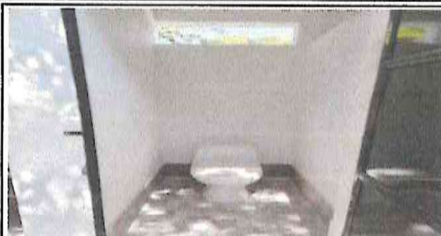
SUSTITUCIÓN DE INODOROS
