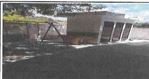
SUSTITUCIÓN DE PILA DE DOS LAVADEROS
