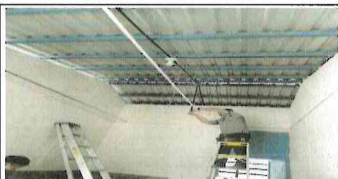
Sustitución de pintura en cocina
