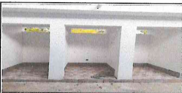
SUSTITUCIÓN DE PISO CERÁMICO EN SERVICIOS SANITARIOS
