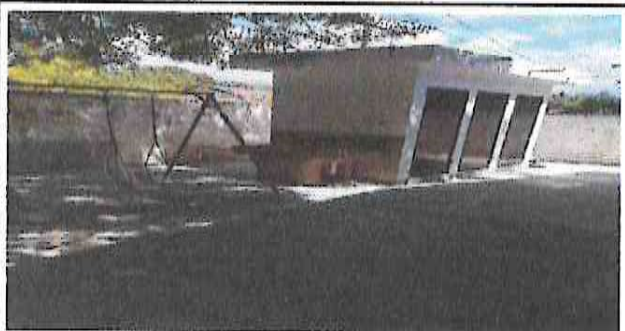
REPARACIÓN DE PISO DE CONCRETO DE PATIO EN BAÑOS
