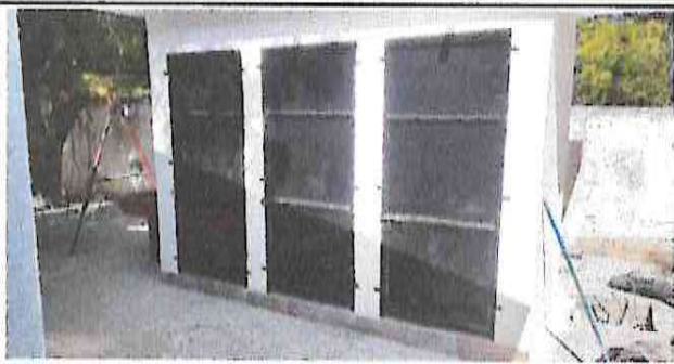
SUSTITUCIÓN DE PUERTAS EN SERVICIOS SANITARIOS Y SUSTITUCIÓN DE LAMINA DURALITA POR LAMINA TROQUELADA
