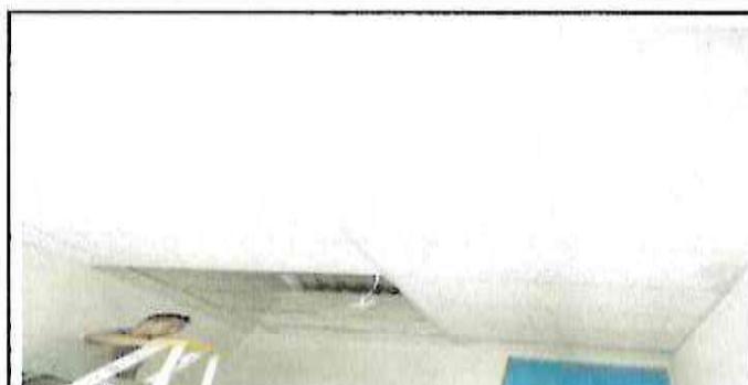
Instalación de cielo falso en techo de cocina,
