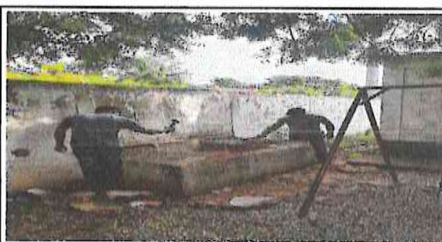
SUSTITUCIÓN DE PILA DE DOS LAVADEROS
