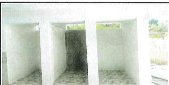
SUSTITUCIÓN DE PISO CERÁMICO EN SERVICIOS SANITARIOS
