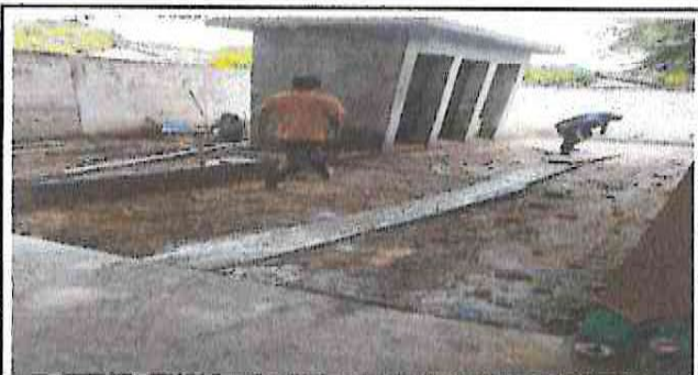
REPARACIÓN DE PISO DE CONCRETO DE PATIO EN BAÑOS
