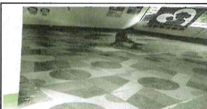
SUSTITUCIÓN DE PISO CERÁMICO EN SALÓN DE CLASES
