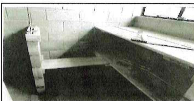
Sustitución de estantes en cocina
