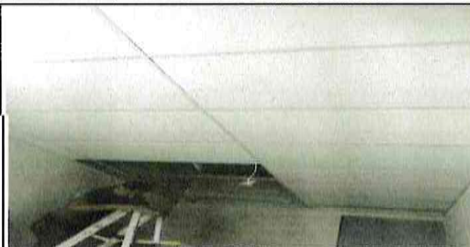
Sustitución de pintura en cocina
