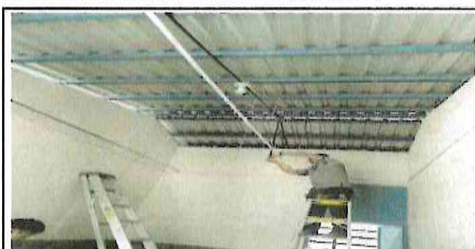
Sustitución de pintura en cocina
