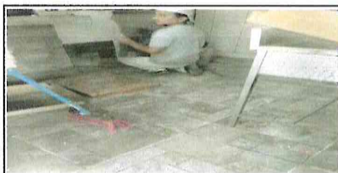
Sustitución de piso cerámico por piso de concreto en cocina
