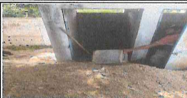
SUSTITUCIÓN DE INODOROS
