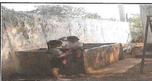
SUSTITUCIÓN DE DEPÓSITO DE AGUA
