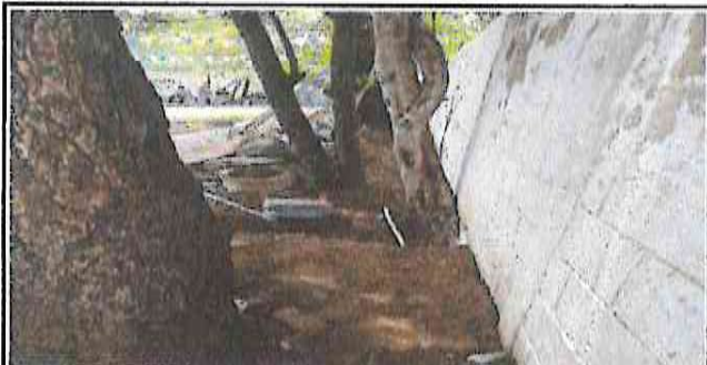
SUSTITUCIÓN DE TUBERÍA PRINCIPAL
