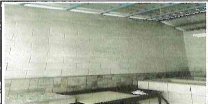
Sustitución de pintura en cocina
