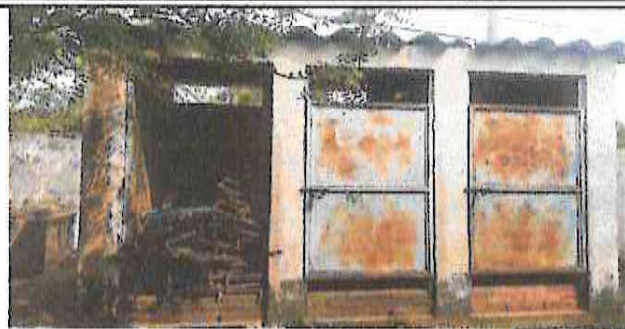
SUSTITUCIÓN DE PUERTAS EN SERVICIOS SANITARIOS Y SUSTITUCIÓN DE LAMINA DURALITA POR LAMINA TROQUELADA
