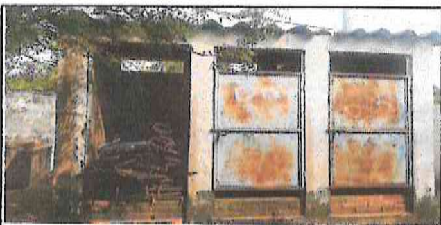
SUSTITUCIÓN DE PISO CERÁMICO EN SERVICIOS SANITARIOS
