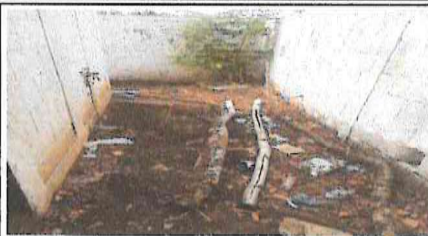
SUSTITUCIÓN DE FOSA SEPTICA Y SU POZO DE ABSORCIÓN
