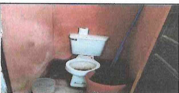
SUSTITUCIÓN DE SANITARIO POR MINGITORIO
