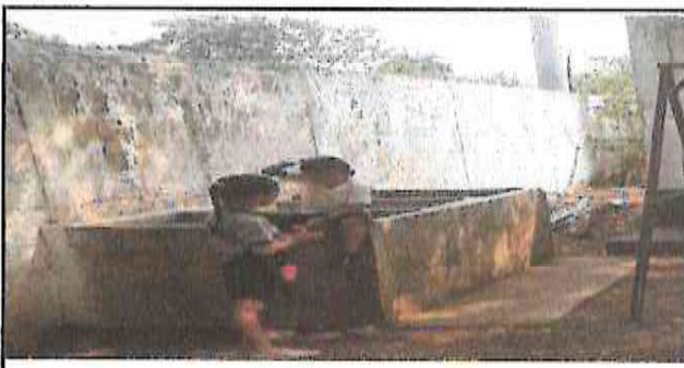
SUSTITUCIÓN DE PILA DE DOS LAVADEROS
