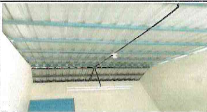
Instalación de cielo falso en techo de cocina,
