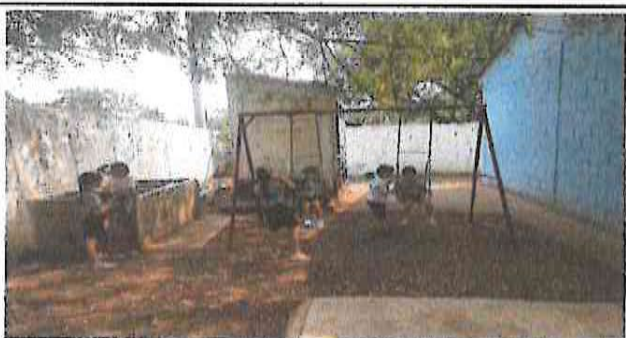
REPARACIÓN DE PLANCHAS DE CONCRETO DE PATIO
