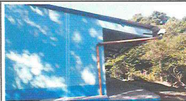
Foto 4: Sustitución de bajada de agua pluvial de tubo PVC de 3"
