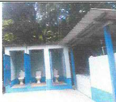
Foto 8: Sustrucción de sanitarios con sus accesorios
