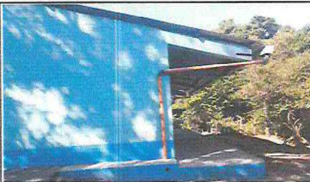
Foto 2: Sustitución de banqueta por daños en la base
