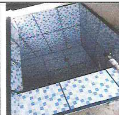
Foto 9: Reparación de pila de concreto de piso líquido por pila de piso de azulejo (Reparación de estructura, picado, cambio de válvula y colocación de azulejo)
