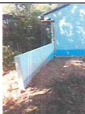
Foto 16: Mantenimiento a muro perimetral de block
