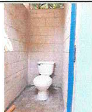
Foto 7: Sustrucción de sanitarios con sus accesorios
