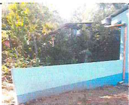
Foto 15: Mantenimiento a muro perimetral de block
