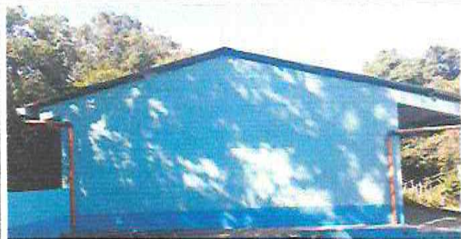
Foto1: Pintura en muros interiores y exteriores
