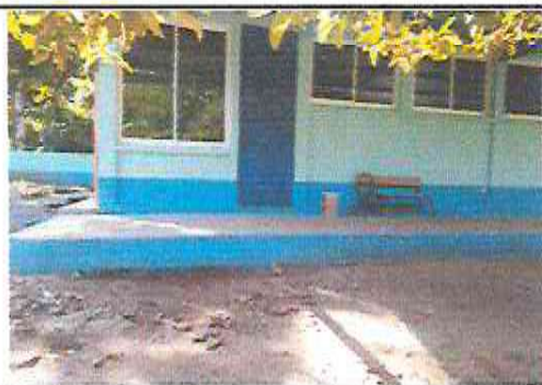
Foto 5: Sustitución de banqueta por daños en la base
