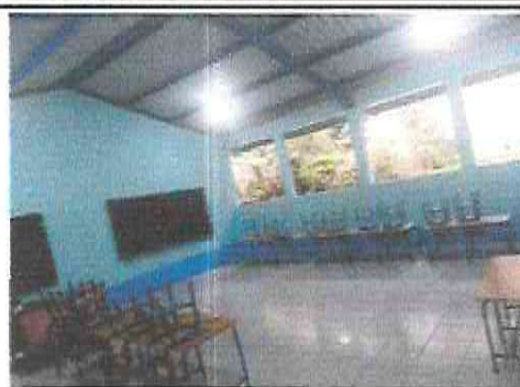
Foto 14: Sustitución de piso liquido de cemento por piso ceramico
