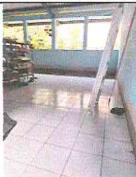
Foto 13: Sustitución de piso liquido de cemento por piso ceramico
