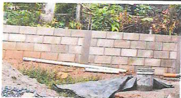
Foto 15: Mantenimiento a muro perimetral de block
