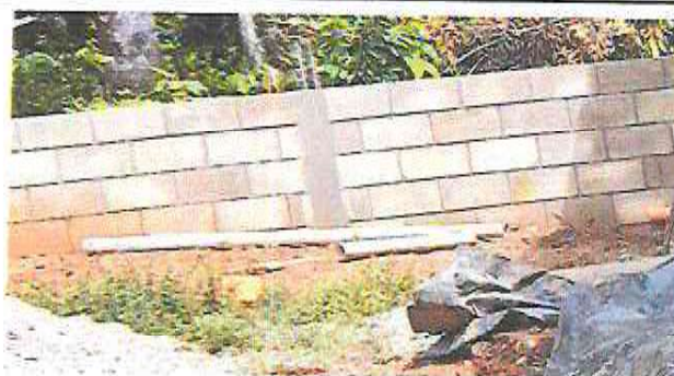
Foto 16: Mantenimiento a muro perimetral de block
