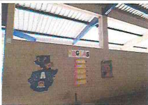
Foto 11: Sustitución de estructura metálica y vidrios dañados por ventanas corredizas de tubo pvc
