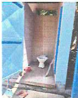
Foto 8: Sustitución de sanitarios con sus accesorios
