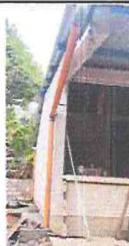
Foto 4: Sustitución de bajada de agua pluvial de tubo PVC de 3"
