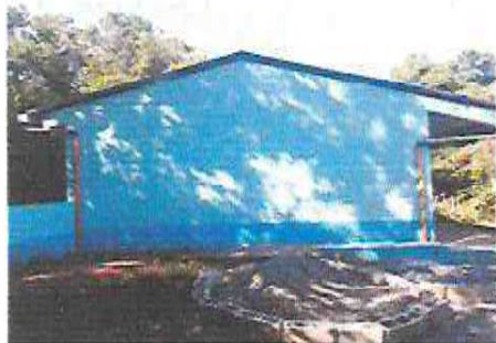
Foto 1: Pintura en muros interiores y exteriores
