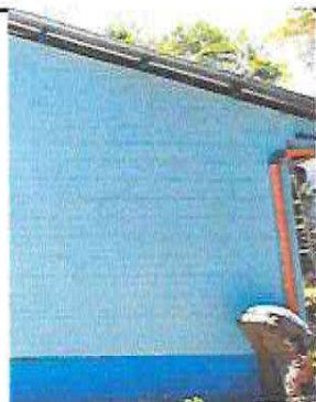
Foto 3: Sustitución de bajada de agua pluvial de tubo PVC de 3"
