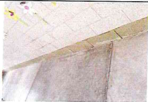
Foto 13: Sustitución de piso líquido de cemento por piso ceramico
