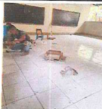
Foto 14: Sustitución de piso líquido de cemento por piso ceramico
