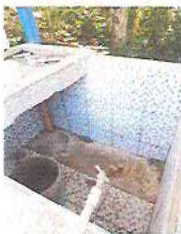
Foto 9: Reparación de pila de concreto de piso líquido por pila de piso de azulejo (Reparación de estructura, picado, cambio de válvula y colocación de azulejo)
