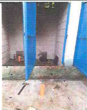
Foto 7: Sustitución de sanitarios con sus accesorios
