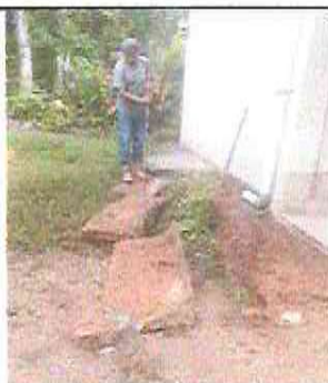
Foto 5: Sustitución de banqueta por daños en la base
