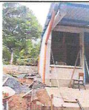
Foto 10: Sustitución de estructura metálica y vidrios dañados por ventanas corredizas de tubo pvc
