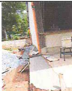
Foto 2: Sustitución de banqueta por daños en la base
