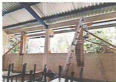
Foto 12: Sustitución de estructura metálica y vidrios dañados por ventanas corredizas de tubo pvc
