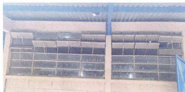
Foto 11: Sustrución de estructura metálica y vidrios dañados por ventanas corredizas de tubo pvc
