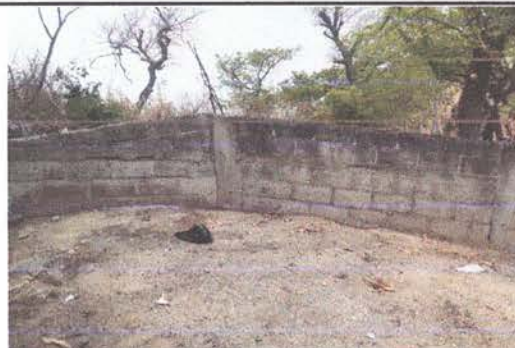
Foto 16: Mantenimiento a muro perimetral de block
