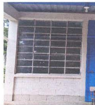
Foto 10: Sustrución de estructura metálica y vidrios dañados por ventanas corredizas de tubo pvc
