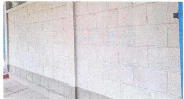
Foto 6: Pintura en muros interiores y exteriores
