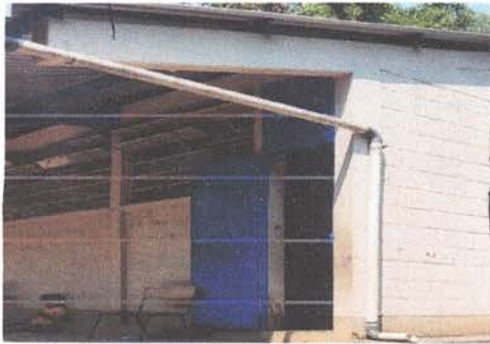
Foto 3: Sustitución de bajada de agua pluvial de tubo PVC de 3"
