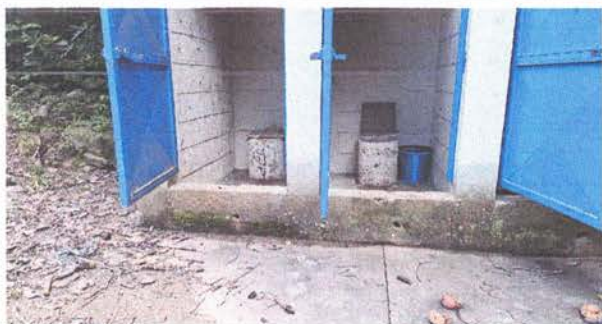
Foto 7: Sustrución de sanitarios con sus accesorios
