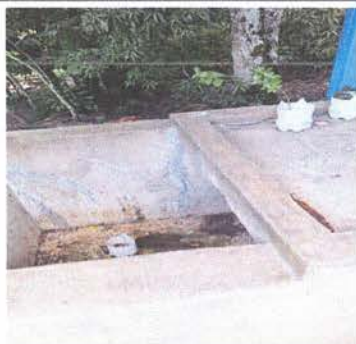
Foto 9: Reparación de pila de concreto de piso líquido por pila de piso de azulejo (Reparación de estructura, picado, cambio de valvula y colocación de azulejo)
