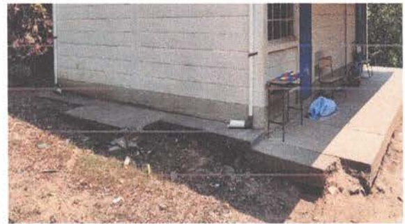
Foto 2: Sustitución de banqueta por daños en la base
