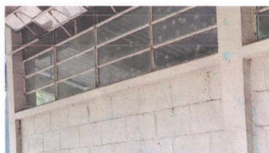
Foto 12: Sustrución de estructura metálica y vidrios dañados por ventanas corredizas de tubo pvc
