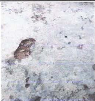
Foto 13: Sustitución de piso líquido de cemento por piso cerámico
