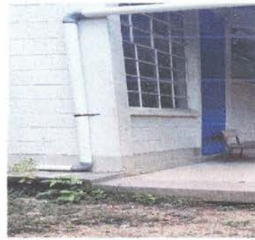
Foto 4: Sustitución de bajada de agua pluvial de tubo PVC de 3"
