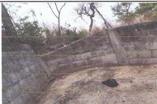
Foto 15: Mantenimiento a muro perimetral de block
