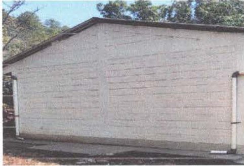
Foto1: Pintura en muros interiores y exteriores
