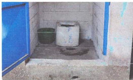
Foto 8: Sustrución de sanitarios con sus accesorios
