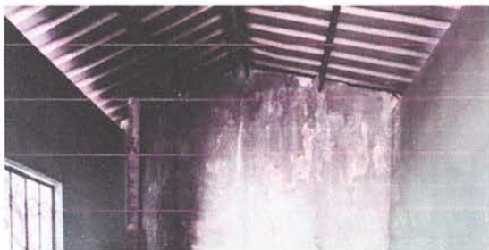
REPARACIÓN DE SISTEMA ELÉCTRICO
