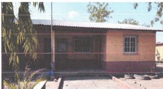
PINTURA EN MUROS EXTERIORES E INTERIORES
