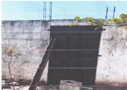
REPARACIÓN DE MURO DE BLOCK
