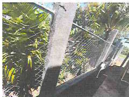
Foto 2: Repello de cemento en muros y cernido en paredes
