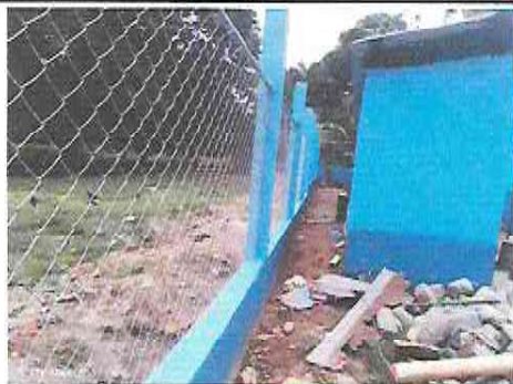
Foto 1: Se reparo malla perimetral
