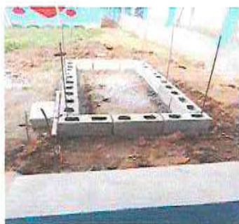
Foto 3: Construcción de Pila
