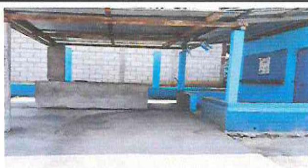
Foto 2: Pintura y construcción de una pila
