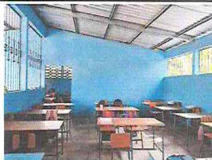
Foto 4: Pintura en paredes interior
