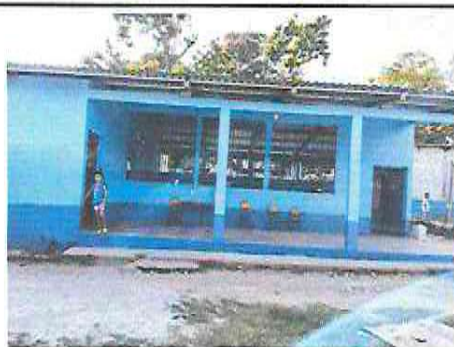
Foto 3: Pintado en pares y muros exterior
