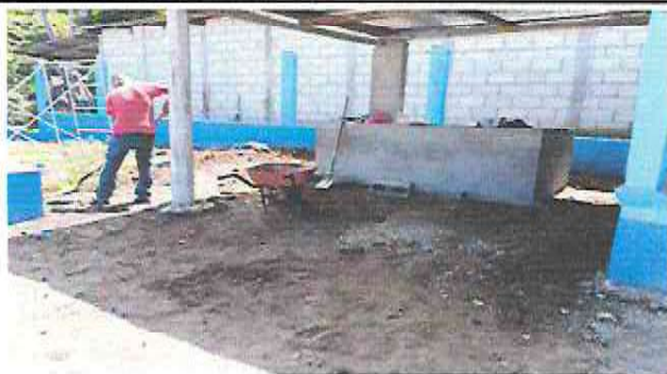
Foto1: Pintura y construcción de una pila
