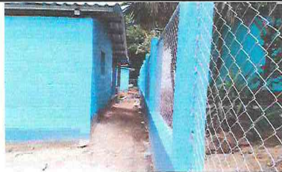
Foto 3: Pintura en la escuela
