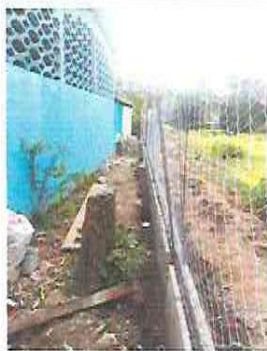
Foto 1: Se reparo malla perimetral
