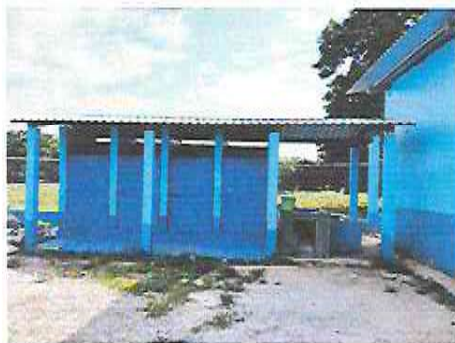
Foto 3: Pintado en pares y muros exterior
