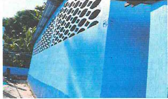
Foto 2: Pintura en la escuela
