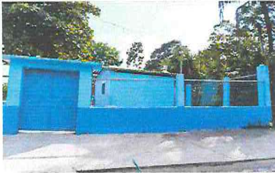
Foto 1: Pintura en la escuela
