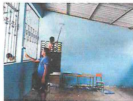
Foto 4: Pintura en paredes interior
