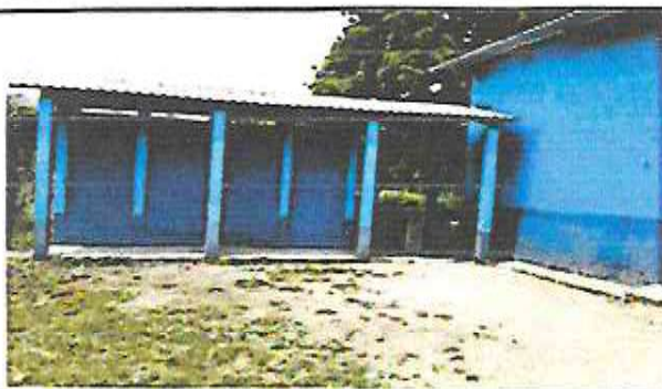
Foto 9: Pintura en muros interiores y exteriores.
