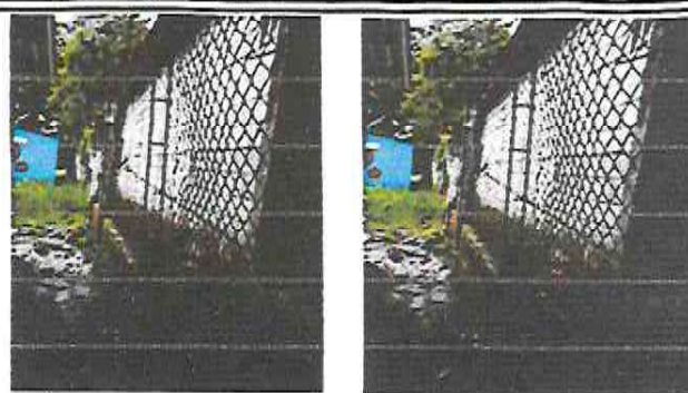
Foto 2: Reparación de muro perimetral de tres hiladas de block y malla galvanizada
