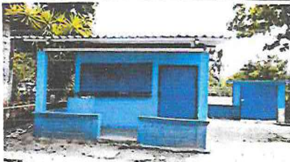
Foto 7: Pintura en muros interiores y exteriores.
