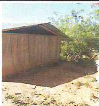
Foto 9: Sustrución de estructura de soporte de madera por metal y de lámina por lámina aluzinc cal 26
