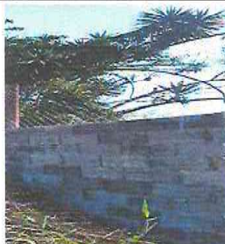
Foto 2: Sustrucción de muro perimetral y malla galvanizada, soleras intermedias y columnas (incluye hierro, arena, piedrin cemento, malla galvanizada)
