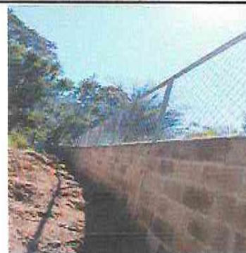
Foto 4: Sustrucción de muro perimetral y malla galvanizada, soleras intermedias y columnas (incluye hierro, arena, piedrin cemento, malla galvanizada)
