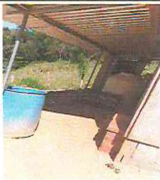
Foto 7: Sustrución de estructura de soporte de madera por metal y de lámina por lámina aluzinc cal 26
