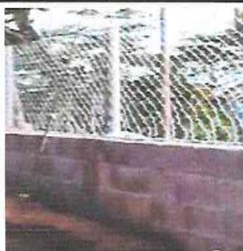
Foto 3: Sustrucción de muro perimetral y malla galvanizada, soleras intermedias y columnas (incluye hierro, arena, piedrin cemento, malla galvanizada)
