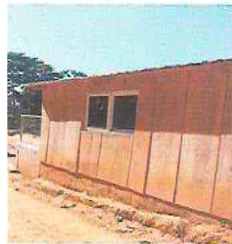
Foto 8: Sustrución de estructura de soporte de madera por metal y de lámina por lámina aluzinc cal 26
