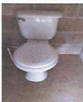
Foto 11: Sustrución de sanitarios con sus accesorios
