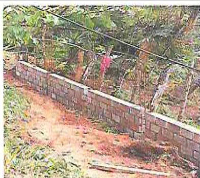
Foto 1: Sustrucción de muro perimetral y malla galvanizada, soleras intermedias y columnas (incluye hierro, arena, piedrin cemento, malla galvanizada)
