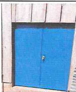
Foto 5: Sustrucción de puerta de metal de 0.90 mts de ancho por 2.15 mts de alto en modulo aulas
