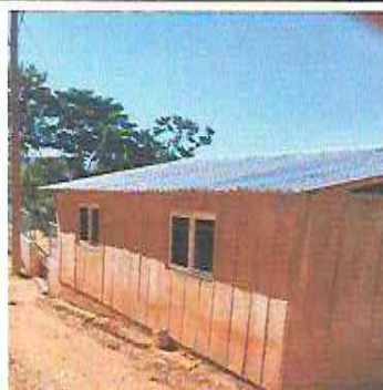
Foto 10: Sustrución de estructura de soporte de madera por metal y de lámina por lámina aluzinc cal 26
