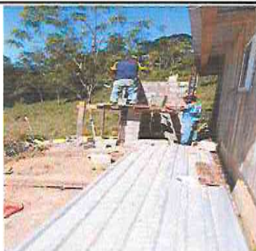
Foto 19: Sustitución de estructura de soporte de metal, sustitución de lámina troquelada aluzinc calibre 26 y levantamiento de paredes
