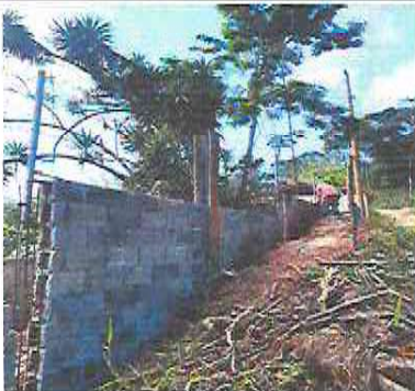
Foto 15: Sustrucción de muro perimetral y malla galvanizada, soleras intermedias y columnas (incluye hierro, arena, piedrin cemento, malla galvanizada)
