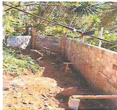
Foto 14: Sustrucción de muro perimetral y malla galvanizada, soleras intermedias y columnas (incluye hierro, arena, piedrin cemento, malla galvanizada)
