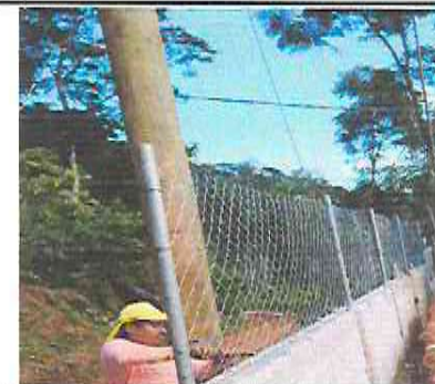
Foto 18: Sustrucción de muro perimetral y malla galvanizada, soleras intermedias y columnas (incluye hierro, arena, piedrin cemento, malla galvanizada)
