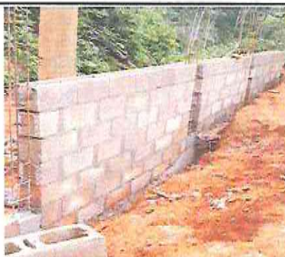
Foto 9: Sustrución de muro perimetral y malla galvanizada, soleras intermedias y columnas (incluye hierro, arena, piedrin cemento, malla galvanizada)
