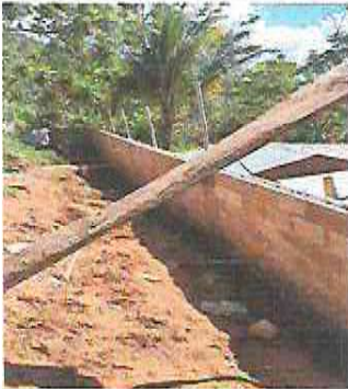
Foto 13: Sustrucción de muro perimetral y malla galvanizada, soleras intermedias y columnas (incluye hierro, arena, piedrin cemento, malla galvanizada)
