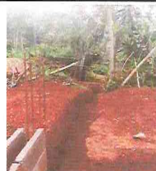
Foto 2: Sustrución de muro perimetral y malla galvanizada, soleras intermedias y columnas (incluye hierro, arena, pedrín cemento, malla galvanizada)
