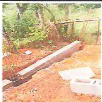
Foto 5: Sustrución de muro perimetral y malla galvanizada, soleras intermedias y columnas (incluye hierro, arena, pedrín cemento, malla galvanizada)
