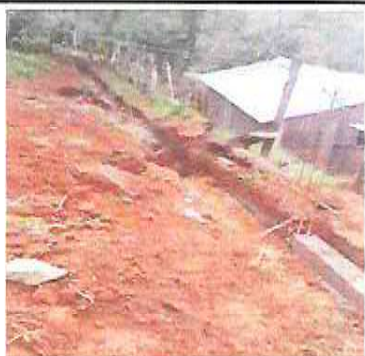
Foto 3: Sustrución de muro perimetral y malla galvanizada, soleras intermedias y columnas (incluye hierro, arena, pedrín cemento, malla galvanizada)
