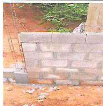
Foto 10: Sustrución de muro perimetral y malla galvanizada, soleras intermedias y columnas (incluye hierro, arena, piedrin cemento, malla galvanizada)
