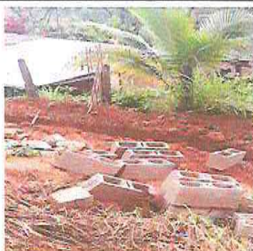
Foto 1: Sustrución de muro perimetral y malla galvanizada, soleras intermedias y columnas (incluye hierro, arena, pedrín cemento, malla galvanizada)
