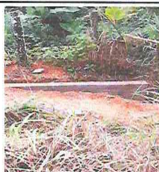
Foto 4: Sustrución de muro perimetral y malla galvanizada, soleras intermedias y columnas (incluye hierro, arena, pedrín cemento, malla galvanizada)
