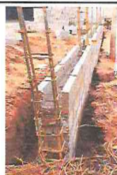
Foto 6: Sustrución de muro perimetral y malla galvanizada, soleras intermedias y columnas (incluye hierro, arena, pedrín cemento, malla galvanizada)
