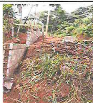
Foto 12: Sustrución de muro perimetral y malla galvanizada, soleras intermedias y columnas (incluye hierro, arena, piedrin cemento, malla galvanizada)
