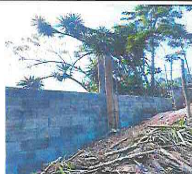
Foto 16: Sustrucción de muro perimetral y malla galvanizada, soleras intermedias y columnas (incluye hierro, arena, piedrin cemento, malla galvanizada)
