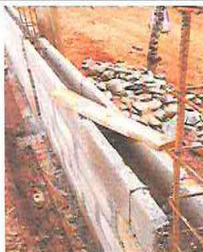
Foto 7: Sustrución de muro perimetral y malla galvanizada, soleras intermedias y columnas (incluye hierro, arena, piedrin cemento, malla galvanizada)
