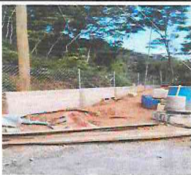
Foto 17: Sustrucción de muro perimetral y malla galvanizada, soleras intermedias y columnas (incluye hierro, arena, piedrin cemento, malla galvanizada)
