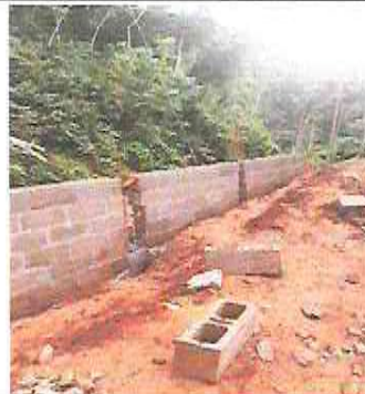
Foto 8: Sustrución de muro perimetral y malla galvanizada, soleras intermedias y columnas (incluye hierro, arena, piedrin cemento, malla galvanizada)
