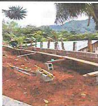
Foto 11: Sustrución de muro perimetral y malla galvanizada, soleras intermedias y columnas (incluye hierro, arena, piedrin cemento, malla galvanizada)
