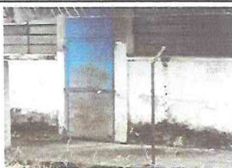
Sustitución de puerta de metal de 0.90 mts de ancho X 2.15 mts de alto
