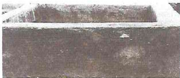
Sustitución de pila de concreto por pila pre-fabricada
