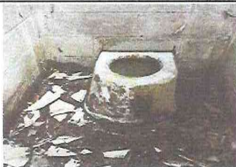
Sustitución de sanitarios con sus accesorios
