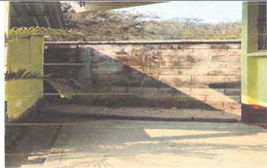
SUSTITUCIÓN DE MURO PERIMETRAL
