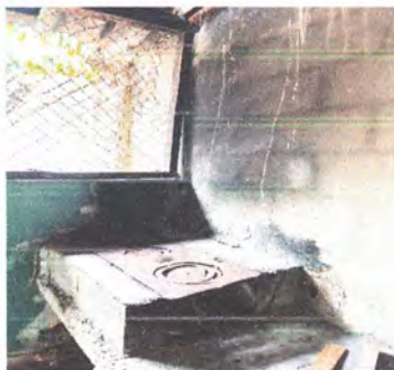
SUSTITUCIÓN DE ESTUFA RURAL COMPLETA (INCLUYE POLLETÓN, PLANCHA DE METAL Y CHIMEMEA)
