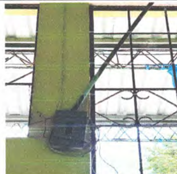
SUSTITUCIÓN DE DUCTO ELECTRICO MÁS ACCESORIOS
