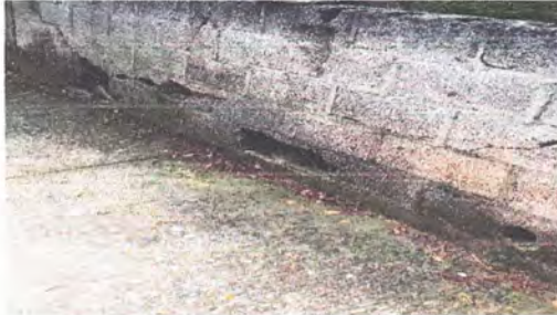
SUSTITUCIÓN DE MURO PERIMETRAL
