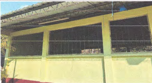
MANTENIMIENTO A BALCONES DE METAL
