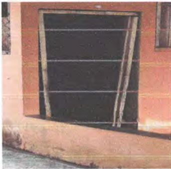
SUSTITUCIÓN DE PUERTA DE MADERA POR METAL
