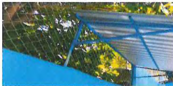
INSTALACIÓN DE GALERA A PILA.
