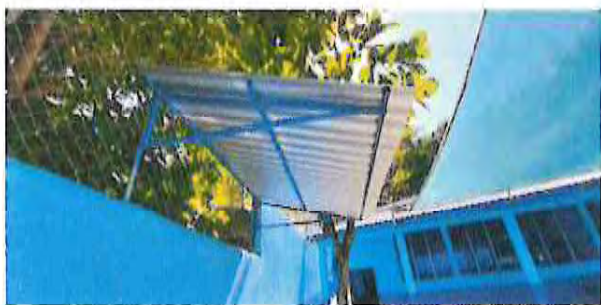
INSTALACIÓN DE GALERA A PILA.
