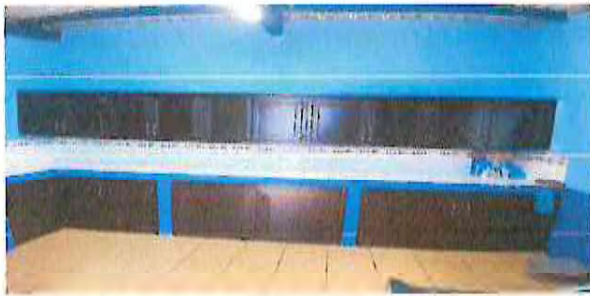
FABRICACIÓN E INSTALACIÓN DE GABIETES AERES 6.0X0.60.
