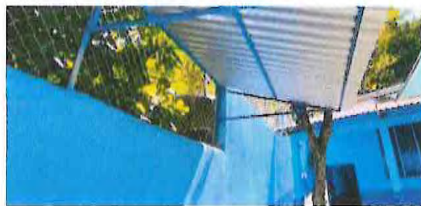
INSTALACIÓN DE GALERA A PILA.
