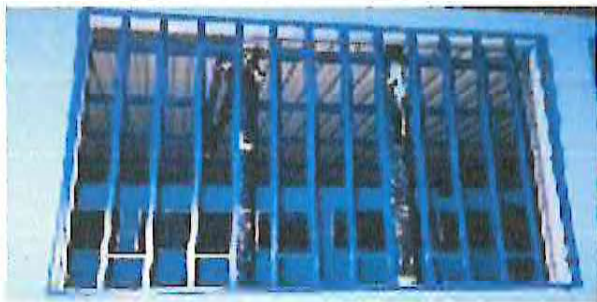
MANTENIMIENTO Y REPARACIÓN A BALCONES DE METAL (LIJADO, CAMBIO DE TUBO, CEPILLADO, SUJETACIONES, APLICACIÓN DE PINTURA).
