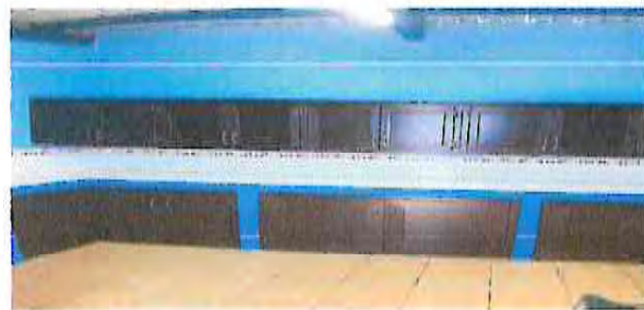
FABRICACIÓN E INSTALACIÓN DE GABIETES AERES 6.0X0.60.
