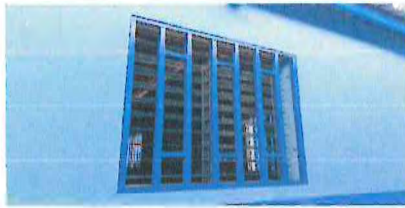
MANTENIMIENTO Y REPARACIÓN A BALCONES DE METAL (LIJADO, CAMBIO DE TUBO, CEPILLADO, SUJETACIONES, APLICACIÓN DE PINTURA).
