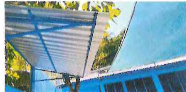
INSTALACIÓN DE GALERA A PILA.
