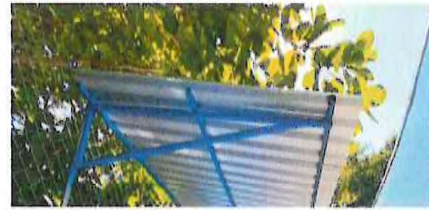
INSTALACIÓN DE GALERA A PILA.
