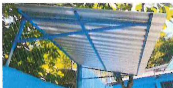
INSTALACIÓN DE GALERA A PILA.
