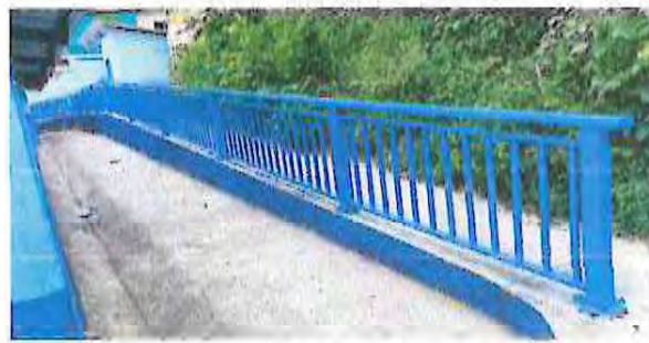
MANTENIMIENTO Y REPARACIÓN A BARANDAL DE METAL (LIJADO, CAMBIO DE TUBO, CEPILLADO, SUJETACIONES, APLICACIÓN DE PINTURA) 60.0X1.90 MTS ALTO.
