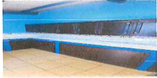
FABRICACIÓN E INSTALACIÓN DE GABIETES AERES 6.0X0.60.
