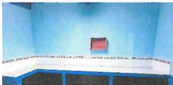
FABRICACIÓN E INSTALACIÓN DE GABINETES AEREOS 6.0X0.60 MTS.
