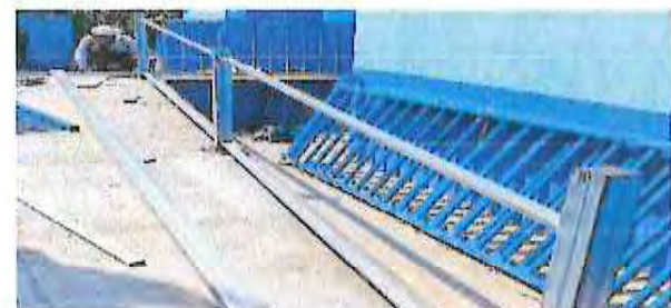
MANTENIMIENTO Y REPARACIÓN A BARANDAL DE METAL (LIJADO CAMBIO DE TUBO, CEPILLADO, SUJETACIONES, APLICACIÓN DE PINTURA) 60.0X1.90 MTS ALTO.
