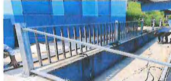
MANTENIMIENTO Y REPARACIÓN A BARANDAL DE METAL (LIJADO CAMBIO DE TUBO, CEPILLADO, SUJETACIONES, APLICACIÓN DE PINTURA) 60.0X1.90 MTS ALTO.
