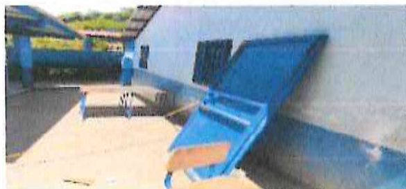
MANTENIMIENTO A ESTRUCTURA (LIJADO, CAMBIO DE TUBO, CEPILLADO, SUJETACIONES, APLICACIÓN DE PINTURA).
