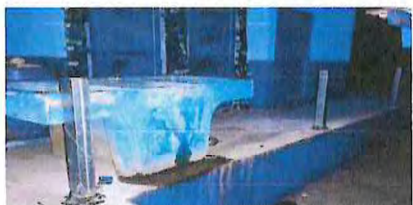
MANTENIMIENTO Y REPARACIÓN A BARANDAL DE METAL (LIJADO CAMBIO DE TUBO, CEPILLADO, SUJETACIONES, APLICACIÓN DE PINTURA) 60.0X1.90 MTS ALTO.
