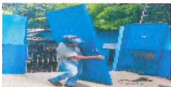
FABRICACIÓN E INSTALACIÓN DE PORTÓN METÁLICO 3.0X3.50.
