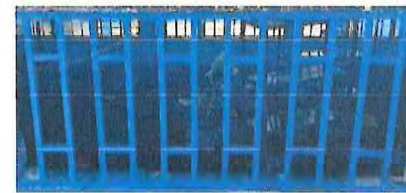
MANTENIMIENTO Y REPARACIÓN A BALCONES DE METAL (LIJADO, CAMBIO DE TUBO, CEPILLADO, SUJETACIONES, APLICACIÓN DE PINTURA).
