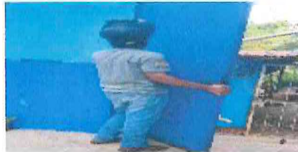
FABRICACIÓN E INSTALACIÓN DE PORTÓN METÁLICO 3.0X3.50.
