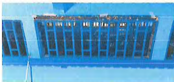
MANTENIMIENTO Y REPARACIÓN A BALCONES DE METAL (LIJADO, CAMBIO DE TUBO, CEPILLADO, SUJETACIONES, APLICACIÓN DE PINTURA).
