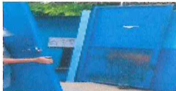
FABRICACIÓN E INSTALACIÓN DE PORTÓN METÁLICO 3.0X3.50.
