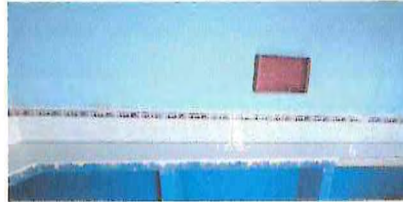
FABRICACIÓN E INSTALACIÓN DE GABINETES AEREO 6.0X0.60 MTS.
