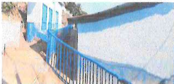
MANTENIMIENTO Y REPARACIÓN A BARANDAL
