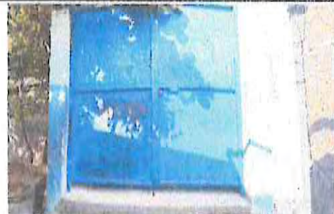
FABRICACION DE PORTON
