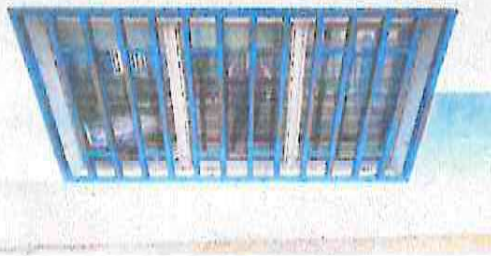
MANTENIMIENTO A BALCONES
