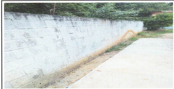
Foto 6: SUSTITUCIÓN DE PINTURA EN INTERIOR DE MURO PERIMETRAL.
