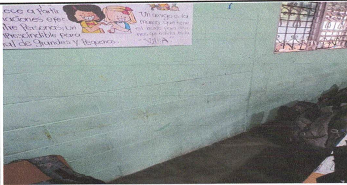
Foto 3: SUSTITUCIÓN DE PINTURA EN INTERIOR DE SALÓN DE CLASES
