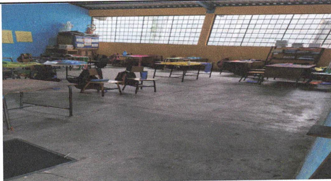
Foto1: SUSTITUCIÓN DE PISO CONCRETO POR PISO CERÁMICO
