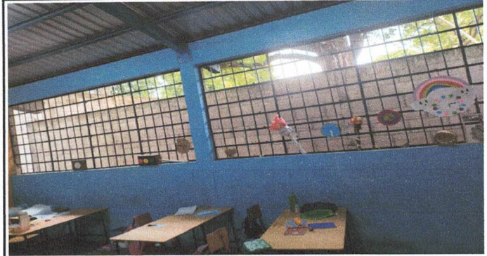
Foto 4: SUSTITUCIÓN DE PINTURA EN INTERIOR DE SALÓN DE CLASES
