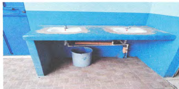
Sustitución de Lavadero por lavadero de concreto con azulejo
