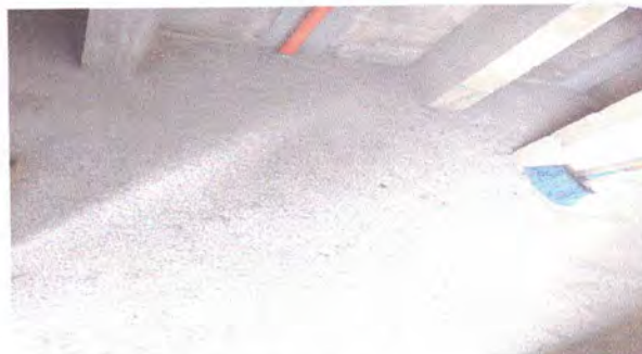
Sustitución de Piso de Granito Por Ceramico
