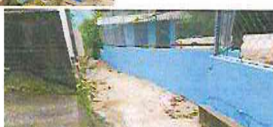
Muro perimetral reparado, tubo y malla galvanizada de rombo de 1" nueva.
