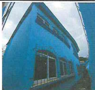
Balcones de atrás del primer y segundo nivel reparados.
