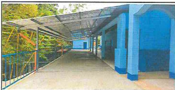
Construcción de ampliación de corredor finalizada.
