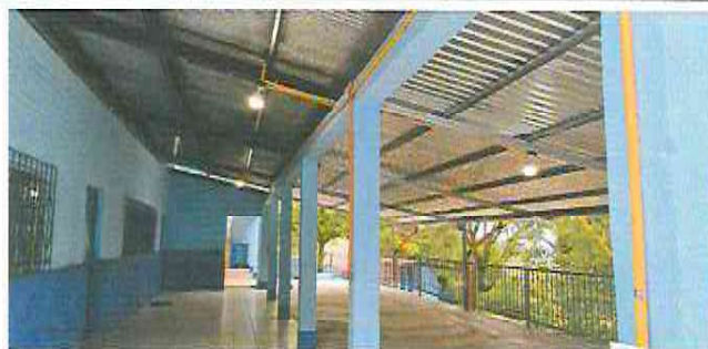
Ducto nuevo y lámparas ahorradoras instaladas.
