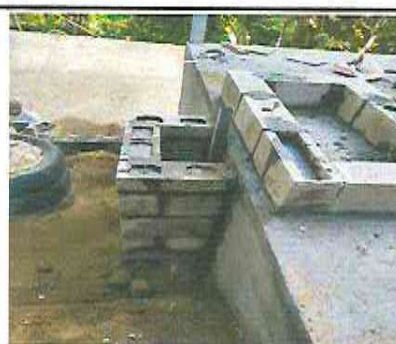
Construcción de base para colocar asta para la bandera.
