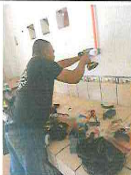
Cambio de switch y tomacorrientes nuevos.
