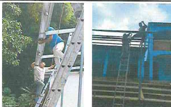
Instalando estructura de metal para constinuidad de techo con lámina troquelada calibre 26
