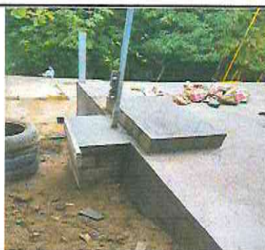
Repellado base para asta de bandera.
