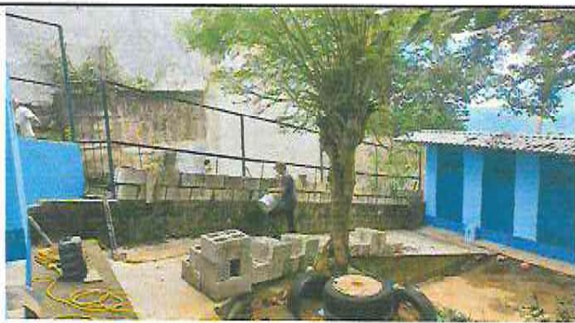
Construcción de 3 hiladas de block en muro perimetral.
