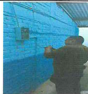
Instalación sistema de flípones nuevos.
