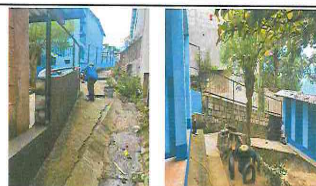
Repellando muro perimetral.
