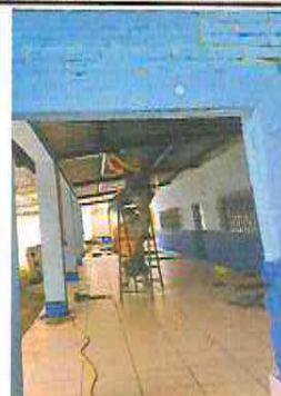
Colocación de lámparas ahorradoras.
