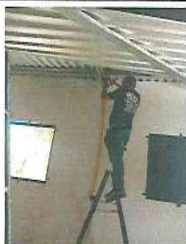
Cambio de ducto electrico.
