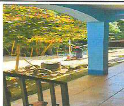
Instalación de base para estructura metalica.
