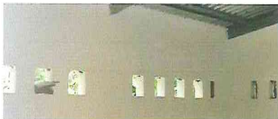
Limpiando para colocar balcones de malla.
