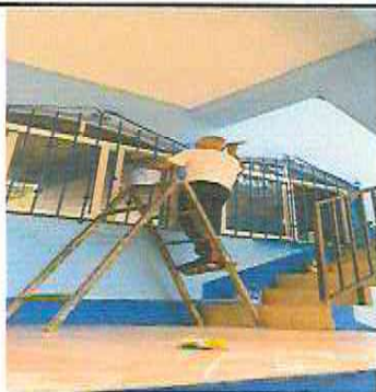
Terminando la reparación con pintura de los balcones del primer y segundo nivel.
