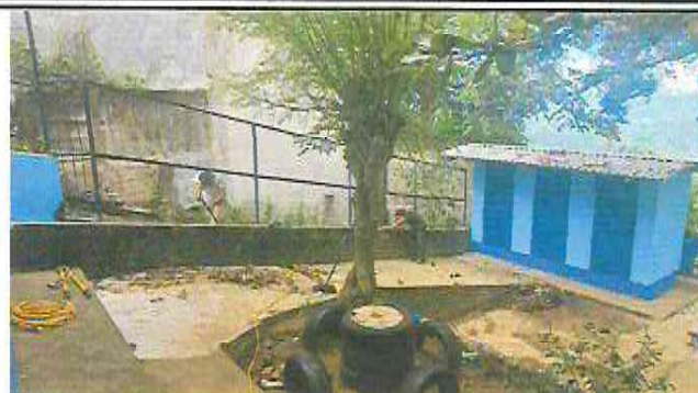
Quitando malla para colocar nueva y poder continuar el muro perimetral con 3 nuevas hiladas de block.
