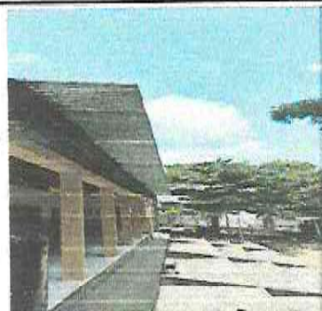
Colocación de canal de metal con bajante de PVC para agua pluvial en terminación de continuación de techo
