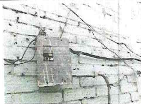
Sustitución de sistema eléctrico (flípones)
