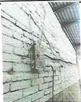
Sustitución de sistema eléctrico (caja de flípones y cableado)
