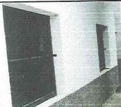
Reparación, lijado, cepillado y pintado de ventanas en cocina
