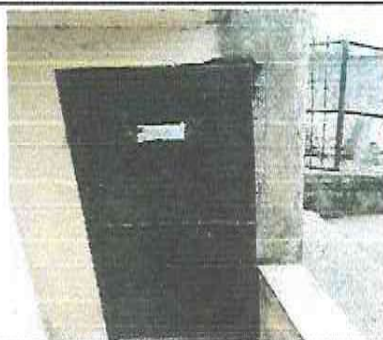
Reparación, lijado, cepillado y pintado de puerta de metal de baño
