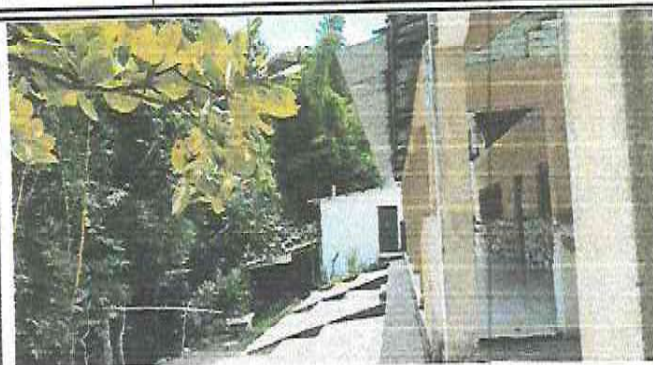
Continuidad de techo con estructura de metal y lámina troquelada
