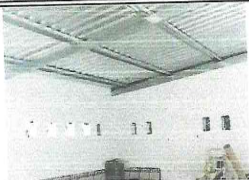
Colocación de balcones de malla en orificios en la cocina
