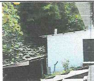
Colocación de cobertor de chimenea
