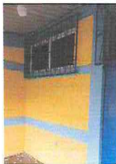
Foto 1: Sustrucción de ventana de metal por ventanas PVC de dos unidades de 3.75x0.80;6
