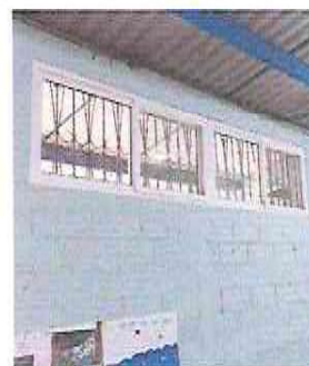
Foto 2: 3.2 Sustitución de ventana de metal por ventana PVC de dos unidades de 1.50x1; 3 c/u
