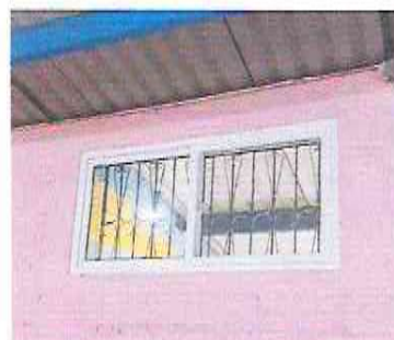
Foto 6: 1.1 Sustitución de ventana de metal por ventanas PVC de dos unidades de 3.75x0.80:6
