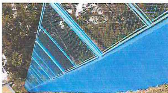
Foto 3: 1.3 Sustitución de maya por deterioro a balcones de maya 2.20x1.5; 30.30 m2 c/u
