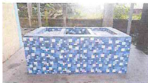
Foto 6: 2.2 Instalación de azulejo a pila de concreto 14 m2
