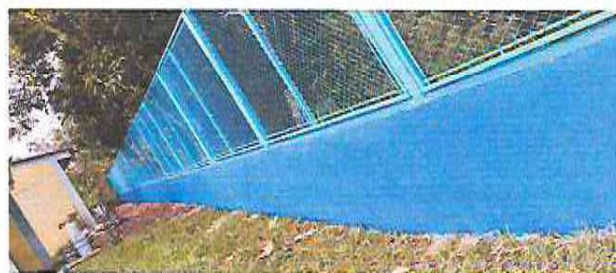
Foto 4: 1.4 Pintura de muro perimetral 100 ML
