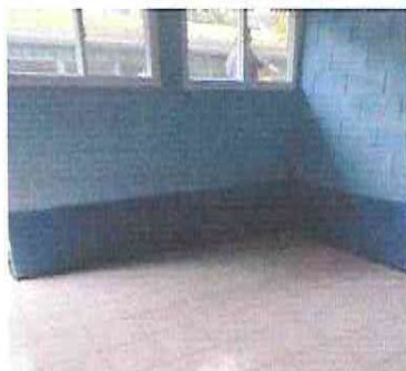
Foto 1: 3.1 Sustitución de torta de concreto por cerámico 4x4.25; 17 m2
