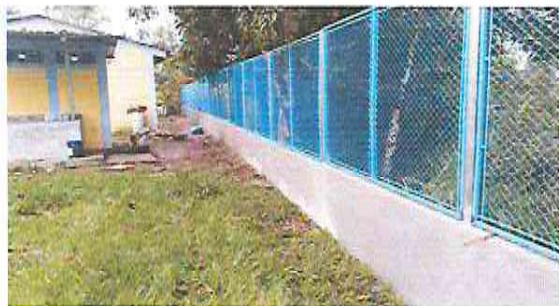
Foto 1: 1.1 Repello de muro perimetral 100 ML
