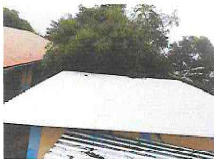
Foto 5: 3.5 Sustitución de lámina ondulada por lámina troquelada aluzinc calibre 26, 6x6:36 m2
