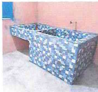
Foto 2: 1.1 Instalación de azulejo a pila de concreto de cocina 8 m2
