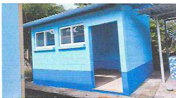
Foto 3: 3.3 Pintura de interiores de dirección 50 m2
