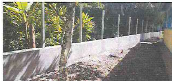
Foto 2: .2 Sustitución de columnas de concreto a columnas de metal 2 mts c/u 20 unidades
