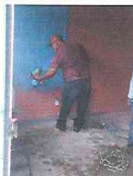
Foto 3: 3.3 Pintura de interiores de dirección 50 m2
