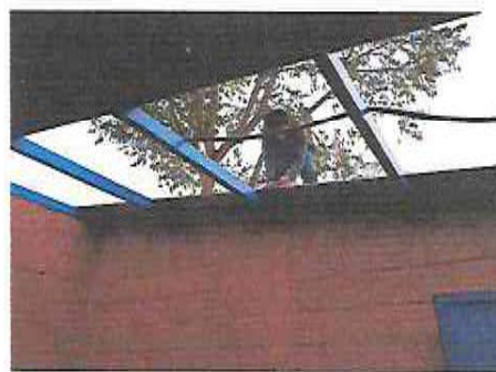
Foto 4: 3.4 Sustitución de estructura de soporte de madera por metal 6x6;36 m2
