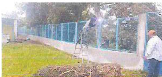
Foto 3: 1.3 Sustitución de maya por deterioro a balcones de maya 2.20x1.5; 30.30 m2 c/u
