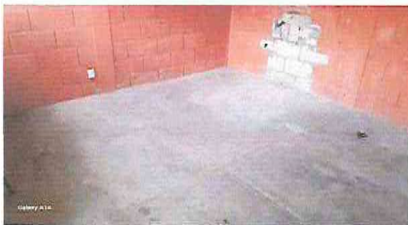
Foto 1: 3.1 Sustitución de torta de concreto por cerámico 4x4.25; 17 m2
