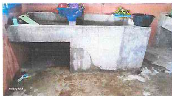
Foto 2: 11.1 Instalación de azulejo a pila de concreto de cocina 8 m2
