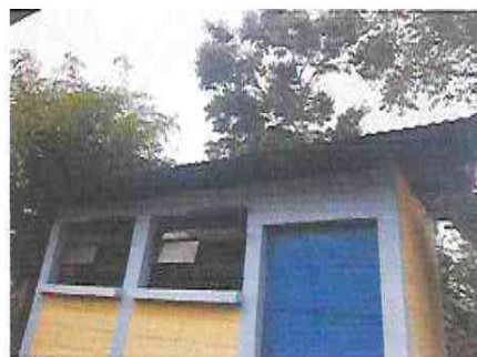
Foto 2: 3.2 Sustitución de ventana de metal por ventana PVC de dos unidades de 1.50x1; 3 c/u
