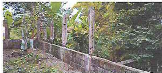
Foto 2: .2 Sustitución de columnas de concreto a columnas de metal 2 mts c/u 20 unidades
