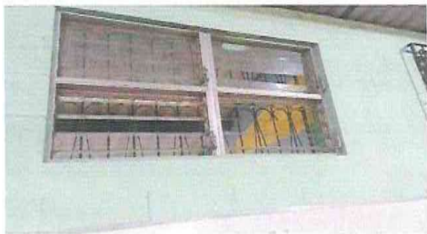
Foto 1: Sustitución de ventana de metal por ventanas PVC de dos unidades de 3.75x0.80;6
