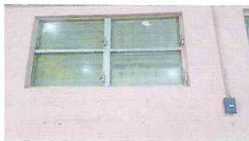
Foto 6: Sustitución de ventana de metal por ventanas PVC de dos unidades de 3.75x0.80;6
