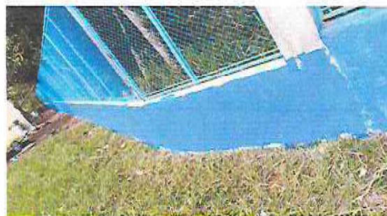
Foto 4: 1.4 Pintura de muro perimetral 100 ML
