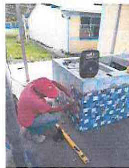
Foto 6: 2.2 Instalación de azulejo a pila de concreto 14 m2
