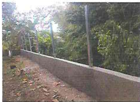
Foto 1: 1.1 Repello de muro perimetral 100 ML
