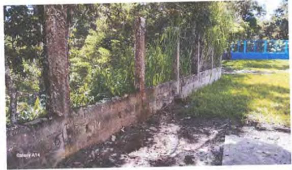
Foto 2: 1.2 Sustitución de columnas de concreto a columnas de metal de 2 mts c/u, 20 unidades
