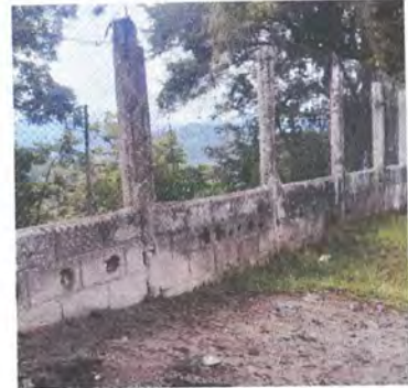
Foto 4: 1.4 Pintura de muro perimetral 100ML
