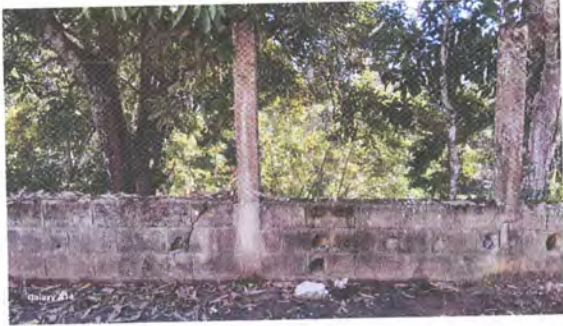
Foto 1: 1.1 Repello de muro perimetral 100ML
