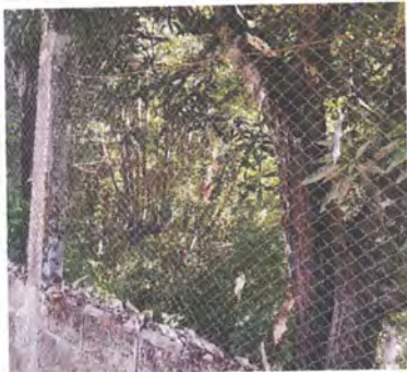
Foto 3: 1.3 Sustitución de maya por deterioro a balcones de maya 2.20 x 1.50; 3.30 M2 c/u.
