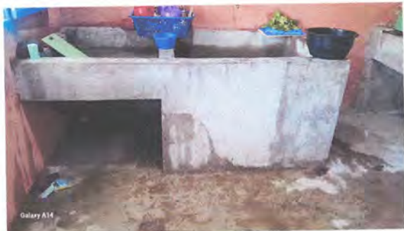
Foto1: Instalación de azulejo a pila de concreto de cocina 8M2
