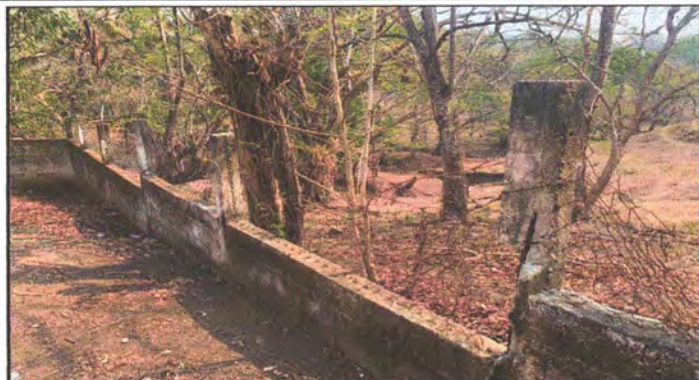
Foto 1: MURO PERIMETRAL DAÑADO, SUSTITUCION DE MALLA Y REPARACION DE BLOCK CON CEMENTO. ✓
