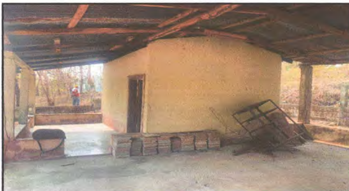
Foto 4: REPARACION DE LAMINA Y ESTRUCTURA
