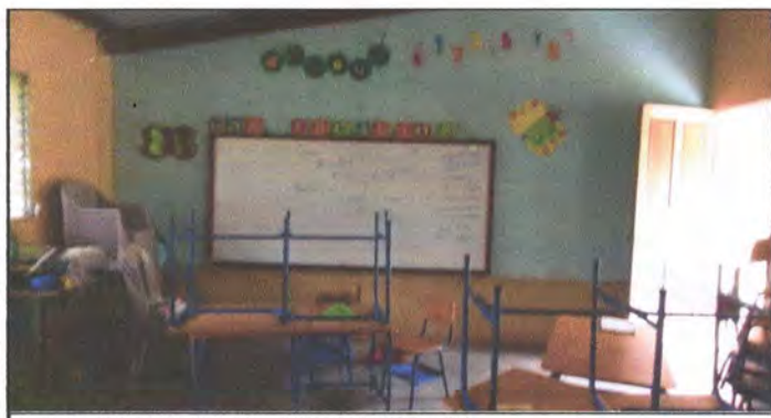
Foto 5: PINTURA DE INTERIOR DE MODULOS
