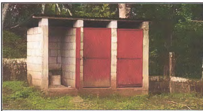
Foto 6: SUSTITUCION DE SANITARIOS Y SUS ACCESORIOS
