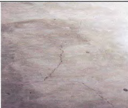
Foto3: sustitución de piso de cemento liquido.
