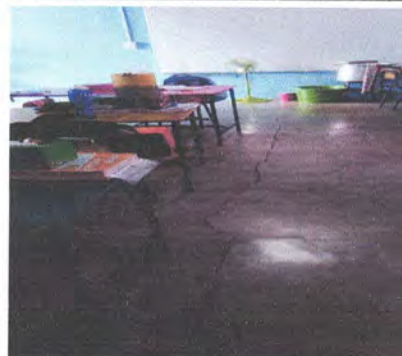
Foto2: sustitución de piso de cemento liquido.
