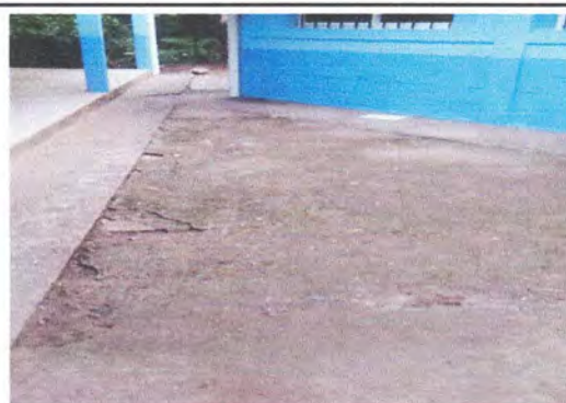
Foto4: sustitución de torta de concreto de cemento.
