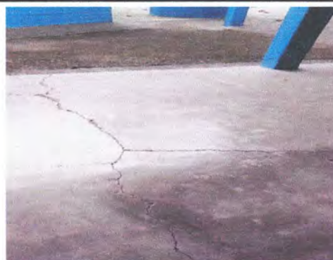
Foto2: sustitución de piso de cemento liquido.
