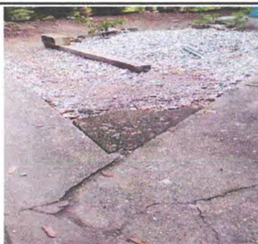
Foto 5: sustitución de torta de concreto de cemento.
