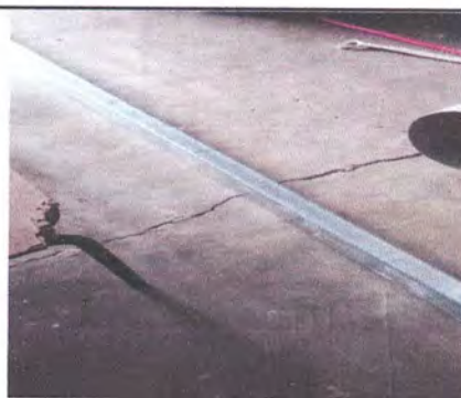
Foto6: sustitución de piso de cemento liquido.
