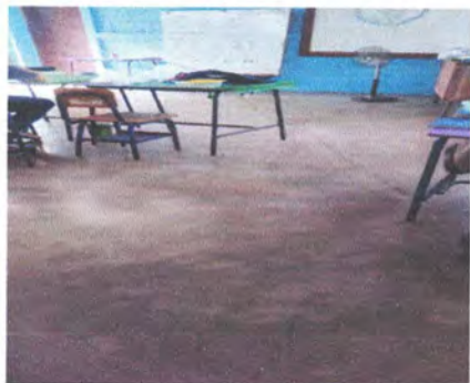
Foto1: sustitución de piso de cemento liquido.
