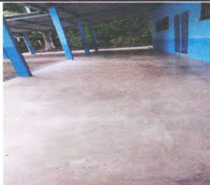
Foto1: sustitución de piso de cemento liquido.
