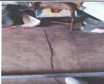
Foto5: sustitución de piso de cemento liquido.
