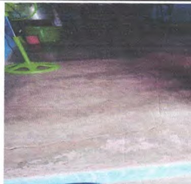
Foto4: sustitución de piso de cemento liquido.
