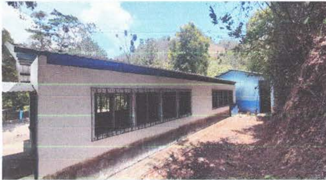
SUSTITUCIÓN DE CANALES DE AGUA
