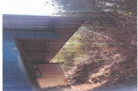
SUSTITUCIÓN DE CANALES DE AGUA
