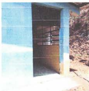
SUSTITUCIÓN DE PUERTA PARA COCINA
