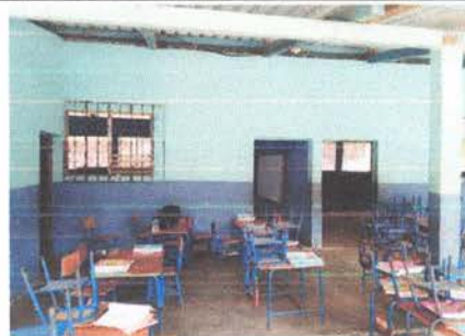
PINTURA EN MUROS INTERIORES Y EXTERIORES
