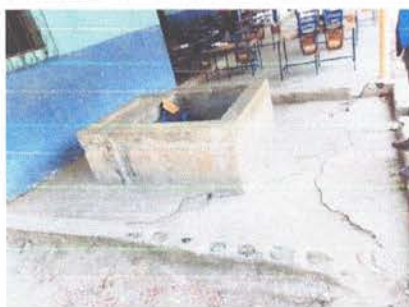
REPARACIÓN DE COCINA
