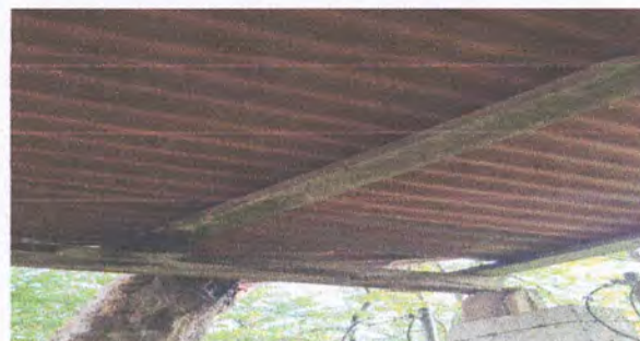
Foto 2: Sustrución o instalación de lámina por lámina troquelada aluzinc calibre 26
