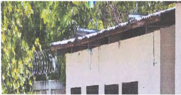
Foto 3: Reparación de techo en módulo de baños
