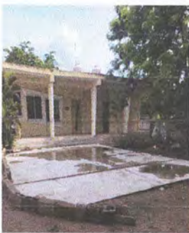
Foto 5: Reparación de piso de torta de concreto
