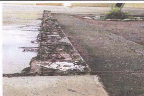
Foto 6: Cajuela de block para piso de concreto
