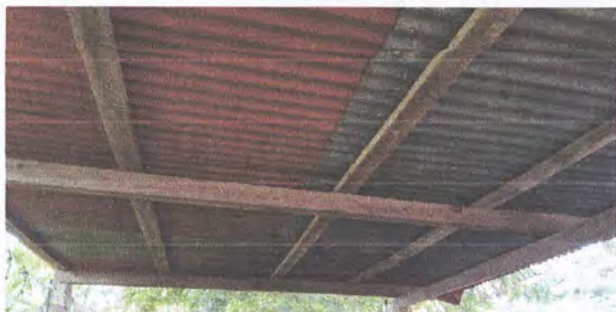
Foto 1: Sustrución o instalación de estructura de soporte de madera por metal
