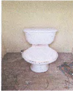
Foto1: Sustitución de inodoros
