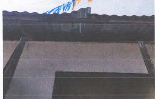
Foto 4: Reparación de techo en módulo de baños
