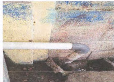
Foto 6: Reparación de tubería de drenaje
