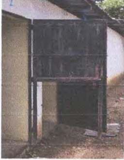
Foto 1: Sustrucción de puerta de metal
