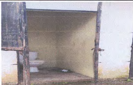
Foto 5: Sustrución de inodoros
