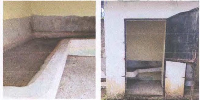
Foto 2: Sustitución de migitorio
