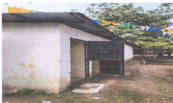
Foto 3: Pintura en muros exteriores e interiores
