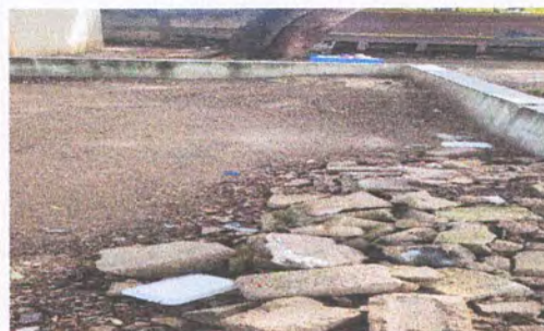
Foto 4: Cajuela de block para piso de concreto
