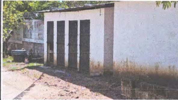
Foto 2: Pintura en muros exteriores e interiores
