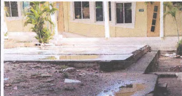
Foto 4: Reparación de piso de torta de concreto
