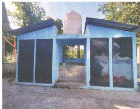
MANTENIMIENTO Y REPARACIÓN A PUERTAS DE METAL EN AREA DE SANITARIOS
