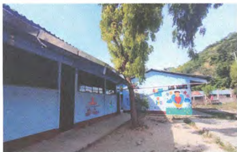
APLICACIÓN DE PINTURA EN MUROS EXTERIORES
