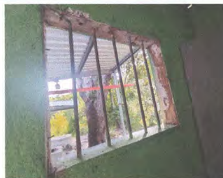
INSTALACIÓN DE VENTANA DE METAL
