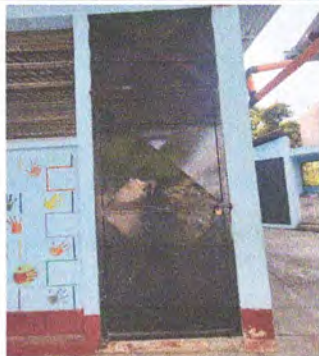
MANTENIMIENTO Y REPARACIÓN A PUERTAS DE METAL DE SALONES
