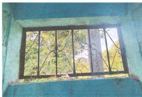
INSTALACIÓN DE VENTANA DE PVC
