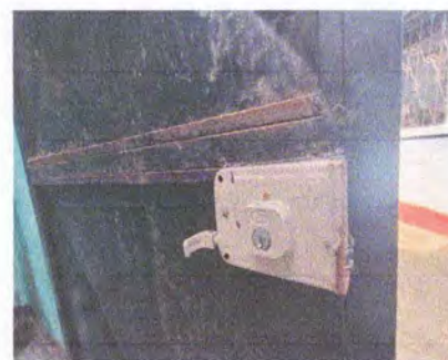
SUSTITUCIÓN DE CHAPAS DE PUERTAS POR PASADOR METALICO
