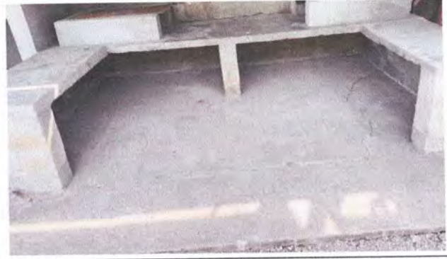
Foto 8: SUSTITUCIÓN O INSTALACIÓN DE PLANCHA DE CONCRETO EN COCINA
