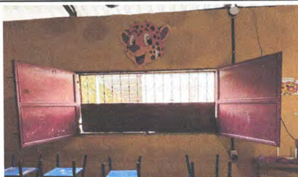
Foto 5 RECONSTRUCCIÓN DE BALCONES DE METAL EN AULAS.
