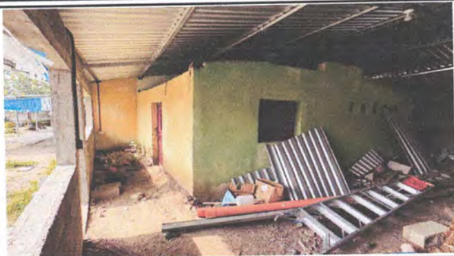
Foto 1: DEMOLICIÓN DE CONSTRUCCIÓN ANTIGUA, y SUSTITUCIÓN DE PISO DE CONCRETO EN AULA.
