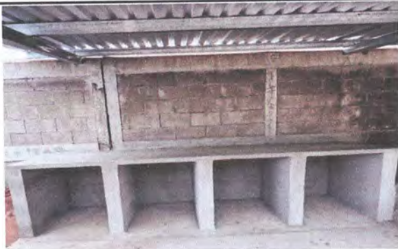
Foto 9: SUSTITUCIÓN O INSTALACIÓN DE AZULEJO EN COCINA.
