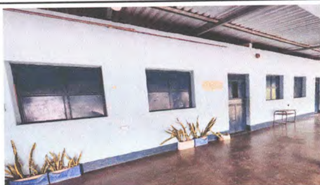
Foto 3: SUSTITUCIÓN DE BALCONES DE METAL EN AULAS.
