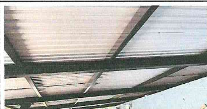
Foto 3: Sustitución de lamina por lamina troquelada calibre 26
