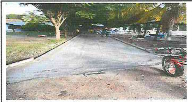
Foto 4: Sustitución de piso de concreto
