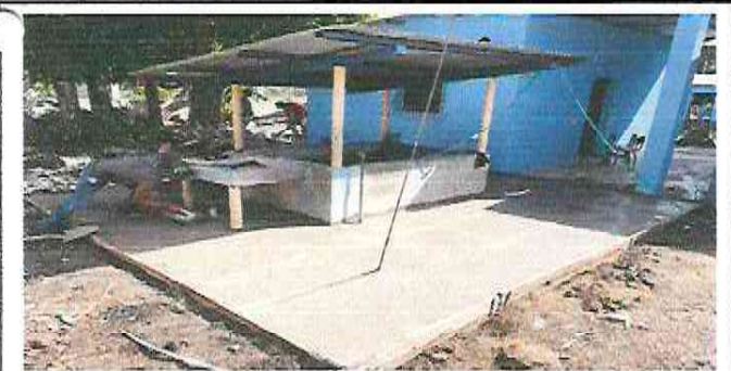
Foto 5: Sustitución de piso de concreto
