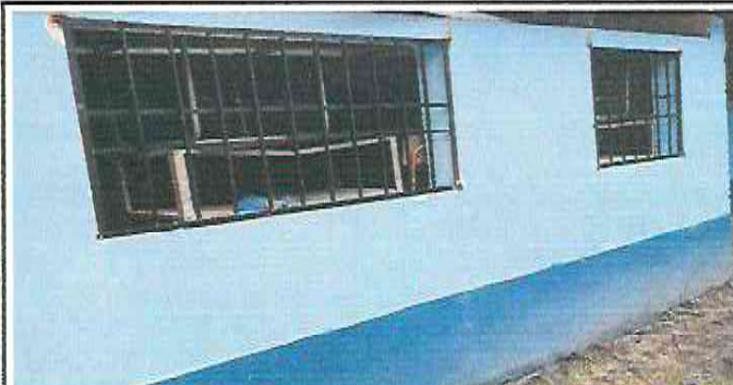
Foto 2: Sustitución de balcones
