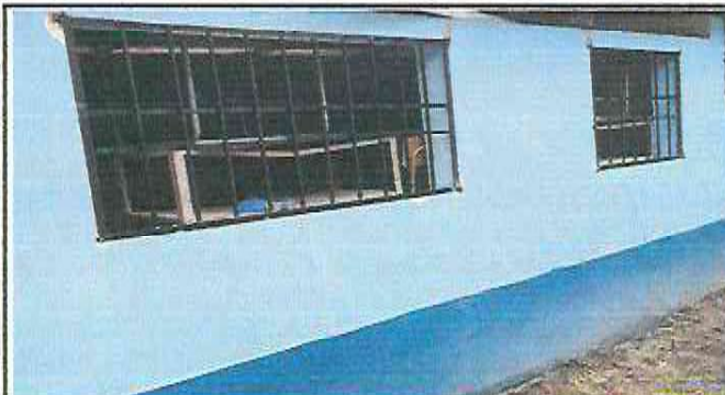
Foto 2: Sustrucción de balcones
