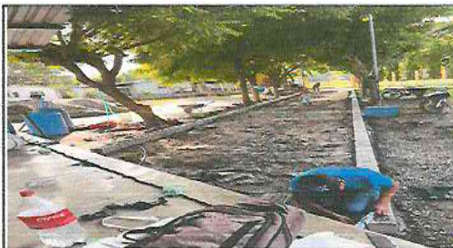
Foto 4: Sustrucción de piso de torta de concreto
