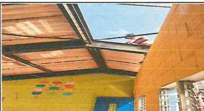
Foto 3: Sustrucción de lamina por lamina troquelada calibre 26
