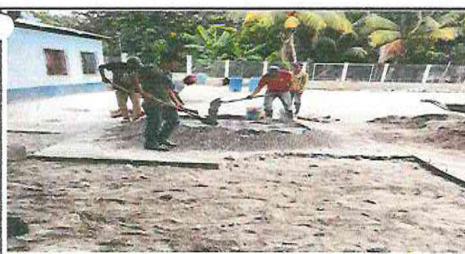
Foto 5: Sustrucción de piso de torta de concreto
