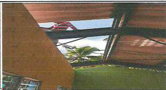
Foto 1: sustucción de laminas troquelada calibre 26
