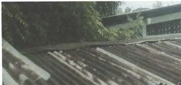
Foto 12: Sustitución de lámina por lámina troquelada aluzinc calibtre 26 en el area de cocina
