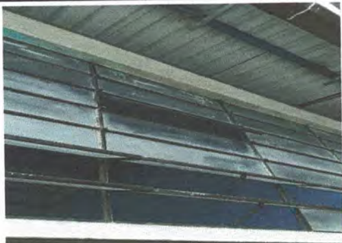
Foto 7: Sustitución de estructura de metal y vidrio (paletas) en 4 ventanas por ventanas de material de PVC corredizas de 2.35 mts de ancho x 1,425 mts de alto. Modulo de cocina
