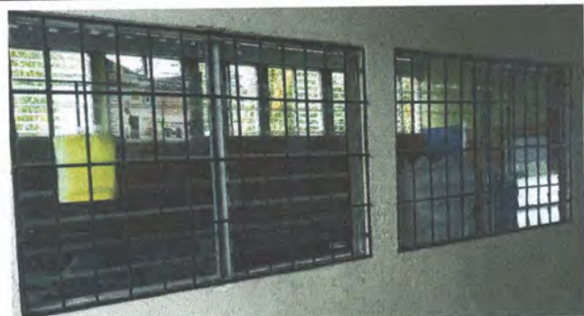
Foto 8: Sustitución de estructura de metal y vidrio (paletas) en 4 ventanas por ventanas de material de PVC corredizas de 2.35 mts de ancho x 1,425 mts de alto, Modulo de aulas
