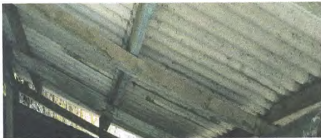
Foto 11: Sustitución de estructura de soporte de madera por metal (costanera) en el área de cocina
