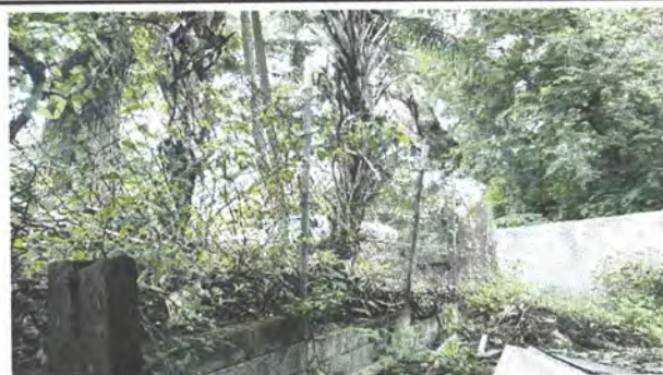
Foto 5: Sustitución de muro perimetral de block dañado por las lluvias (Incluye block, cemento, piedrín, arena, hierro y mano de obra calificada)
