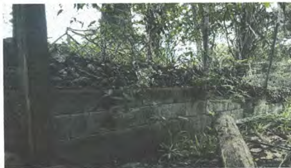
Foto 4: Sustitución de muro perimetral de block dañado por las lluvias (Incluye block, cemento, piedrín, arena, hierro y mano de obra calificada)
