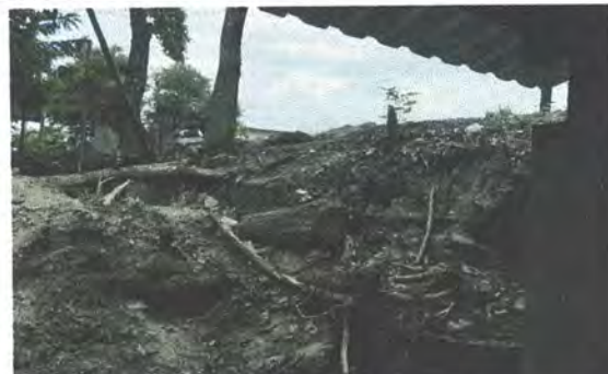
Foto 2: Sustitución de muro perimetral de block dañado por las lluvias (Incluye block, cemento, piedrín, arena, hierro y mano de obra calificada)
