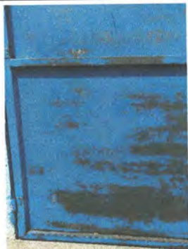
Foto 9: Sustitución de puerta de metal de 2.05 mts de alto y 1.02 mts de ancho en el area de cocina
