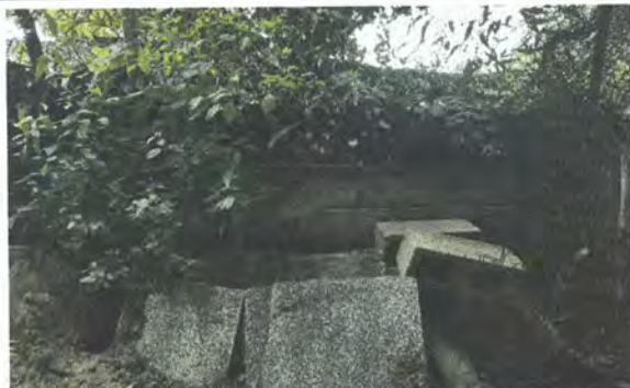
Foto 3: Sustitución de muro perimetral de block dañado por las lluvias (Incluye block, cemento, piedrín, arena, hierro y mano de obra calificada)
