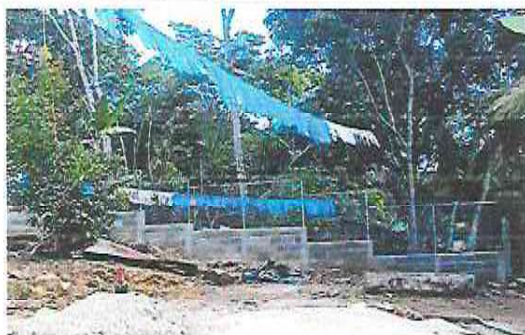
Foto 1: Sustrucción de muro perimetral de block con malla galvanizada de 1.50 mts de alto con agujero de 3 pulgadas
