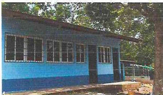
Foto 9: Pintura en muros interiores y exteriores
