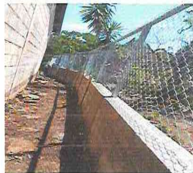
Foto 14: Sustitución de muro perimetral de block con malla galvanizada de 1.50 mts de alto con agujero de 3 pulgadas
