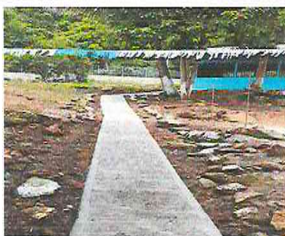
Foto 11: Suministro e instalación de caminamiento entrada principal
