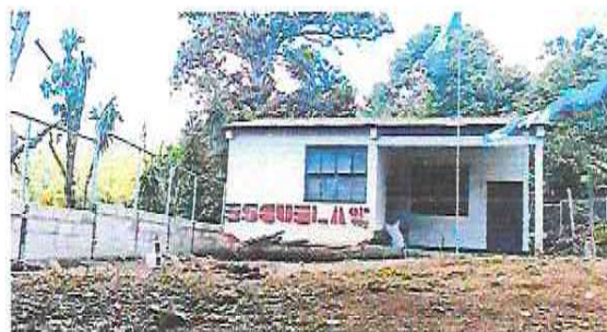
Foto 4: Sustrucción de muro perimetral de block con malla galvanizada de 1.50 mts de alto con agujero de 3 pulgadas
