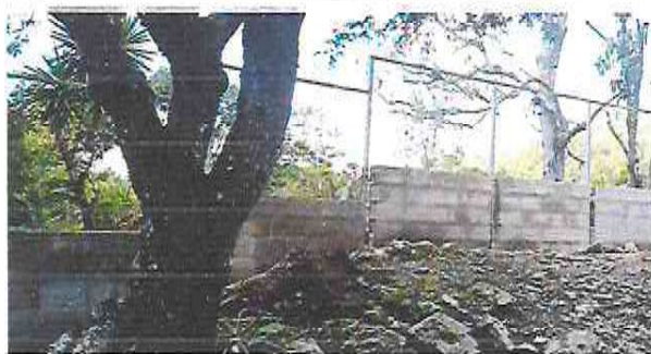
Foto 3: Sustrucción de muro perimetral de block con malla galvanizada de 1.50 mts de alto con agujero de 3 pulgadas
