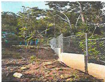
Foto 7: Sustrucción de muro perimetral de block con malla galvanizada de 1.50 mts de alto con agujero de 3 pulgadas
