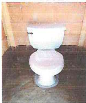
Foto 13: Sustitución de sanitarios con sus accesorios
