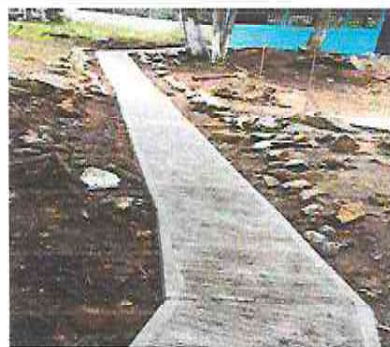
Foto 10: Suministro e instalación de caminamiento entrada principal
