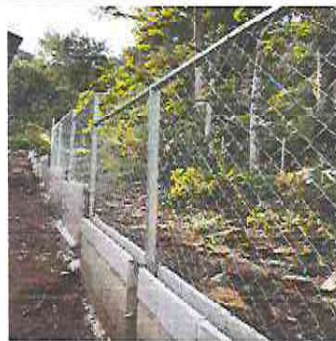
Foto 8: Sustrucción de muro perimetral de block con malla galvanizada de 1.50 mts de alto con agujero de 3 pulgadas
