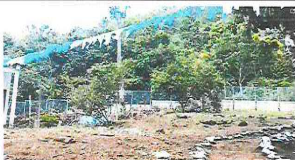
Foto 5: Sustrucción de muro perimetral de block con malla galvanizada de 1.50 mts de alto con agujero de 3 pulgadas
