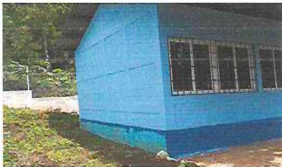
Foto 5: Pintura en balcones y pintura en aulas interiores y exteriores
