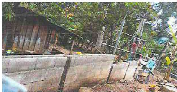
Foto 1: Sustitución de muro perimetral de block con malla galvanizada de 1.50 mts de alto con agujero de 3 pulgadas
