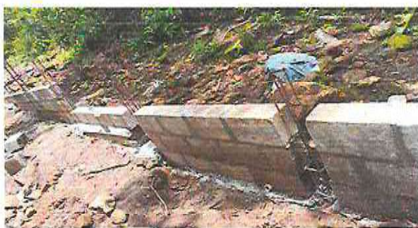
Foto 3: Sustitución de muro perimetral de block con malla galvanizada de 1.50 mts de alto con agujero de 3 pulgadas
