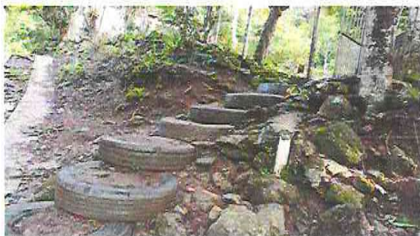
Foto 7: Suministro e instalación de gradas entrada principal
