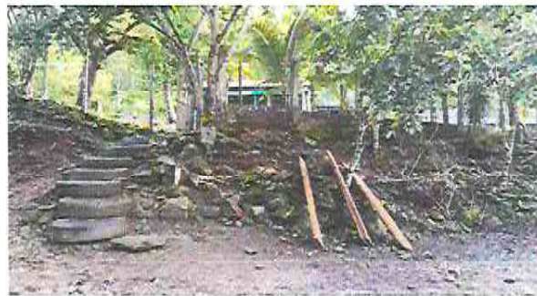
Foto 6: Suministro e instalación de gradas entrada principal
