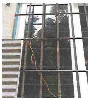
Foto 9: Pintura en balcones y pintura en aulas interiores y exteriores
