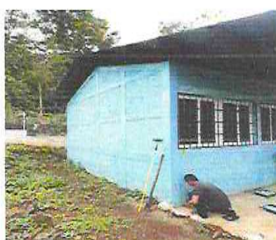
Foto 8: Pintura en balcones y pintura en aulas interiores y exteriores
