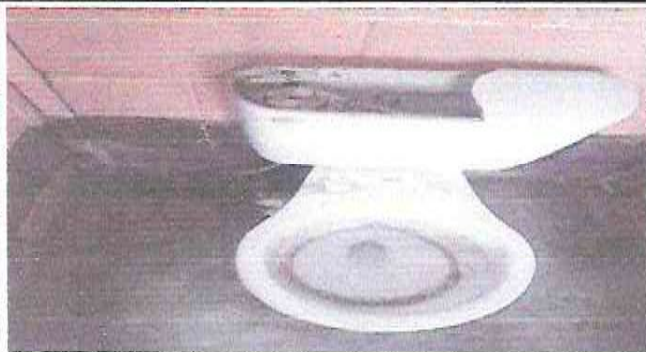
Foto 07: Sustitución de sanitarios y sus accesorios.
