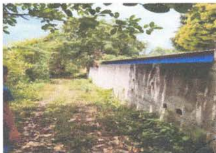
ALAMBRE DE PUAS EN MURO PERIMETRAL
