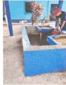
SUSTITUCIÓN DE PILA DE DOS LAVADEROS
