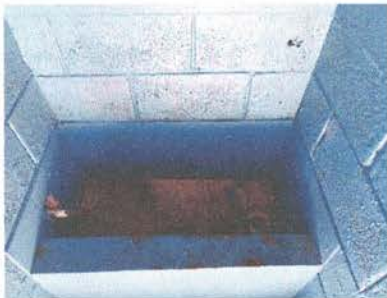
SUSTITUCIÓN DE AZULEJO
