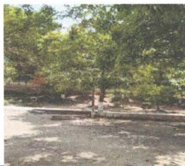
CUNETA DE CONCRETO
