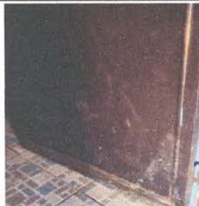
MANTENIMIENTO A PUERTAS
