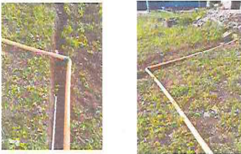
Foto 17: InstalaciOn de drenage y tuberla de agua para la cocina
