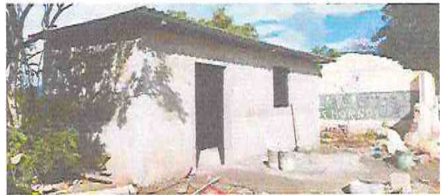
Foto 16: contrucción de cocina
