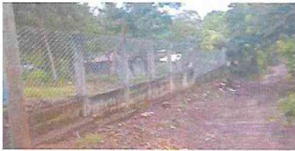
Foto 9: Instalación y sustitución de maya del muro perimetral del centro educativo área de enfrente
