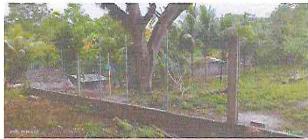
Foto 10: Instalación de maya del muro perimetral área lateral del centro educativo
