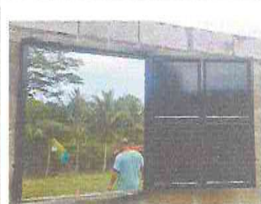
Foto 4: Mantenimiento de puertas de metal, lijado, cepillado y aplicación de pintura.
