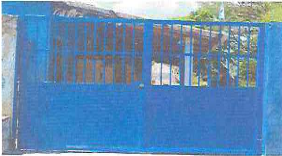
Foto 1: Instalación y sustitución de portón del centro educativo
