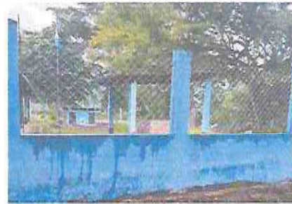
Foto 8: Instalación y sustitución de maya del muro perimetral
