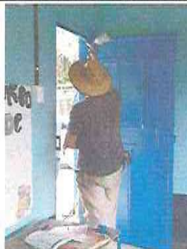
Foto 2: Lijado y pintado de puertas en interior y exterior del cenetro educativo
