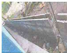
Foto 11: Muro de contención listo para colocar tubos y maya
