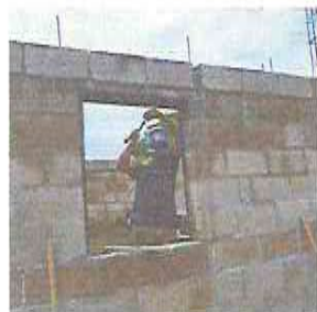
Foto 7: Colocación e instalación de ventana de cocina
