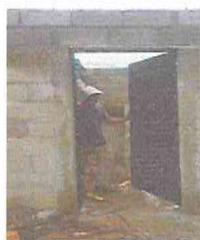
Foto 6: Instalación de puerta de cocina del centro educativo puntada interior y exterior
