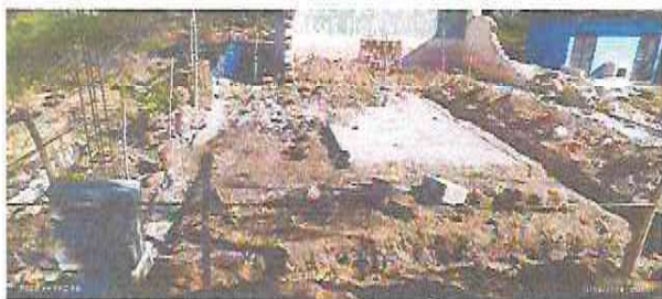
Foto 13: Inicio de construcción de cocina
