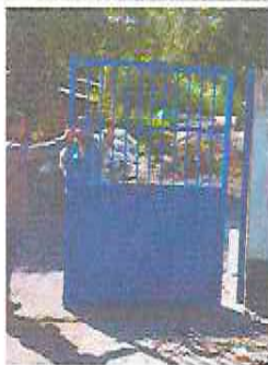
Foto 1: Instalacion de portón
