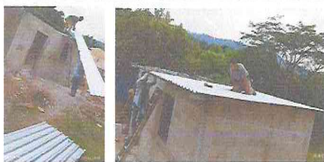
Foto 17: Instalación de lamina del área cocina
