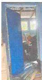
Foto 3: Lijado y pintado de puertas en interior y exterior del cenetro educativo
