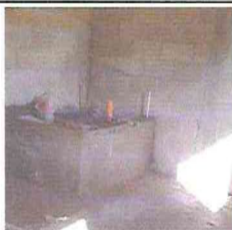
Foto 21: construcción de pila adentro de la cocina
