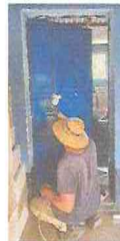
Foto 4: Lijado y pintado de puertas en interior y exterior del cenetro educativo
