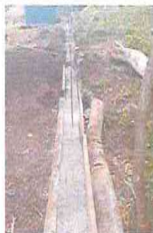
Foto 10: cimbrado del muro de contención
