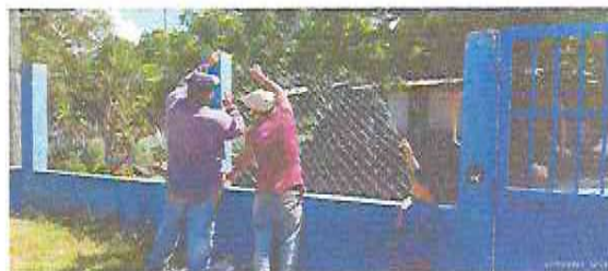
Foto 22: instalacion y sustitución de maya del muro perimetral del centro educativo
