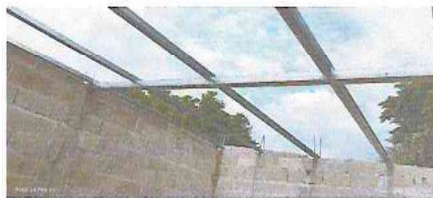
Foto 16: Instalacion de costaneras del area de la cocina
