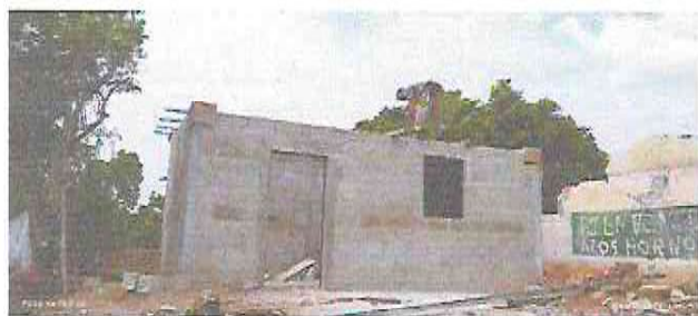
Foto 15: Instalacion de costaneras cocina
