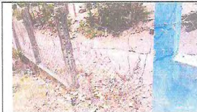
Foto 2: Muro perimetral de la escuela
