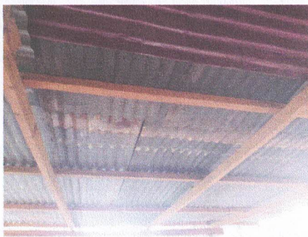
Foto 3: Sustitución de estructura de techo de madera por estructura de metal
