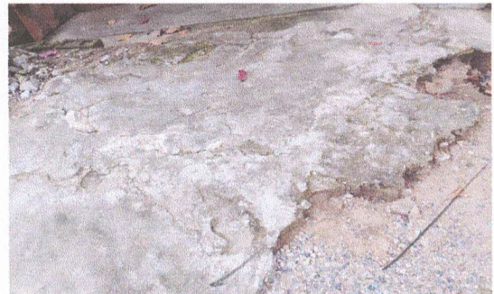
Foto: 2 Reparación de torta de concreto
