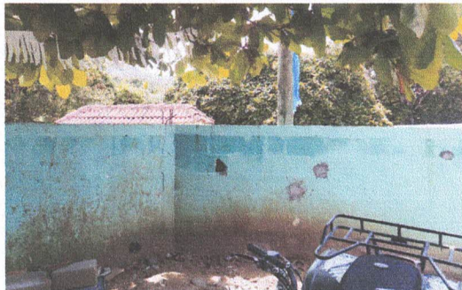
Foto1: Instalación de maya y tubería en muro perimetral
