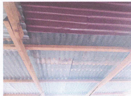
Foto 4: Sustitución de lámina por lámina troquila
