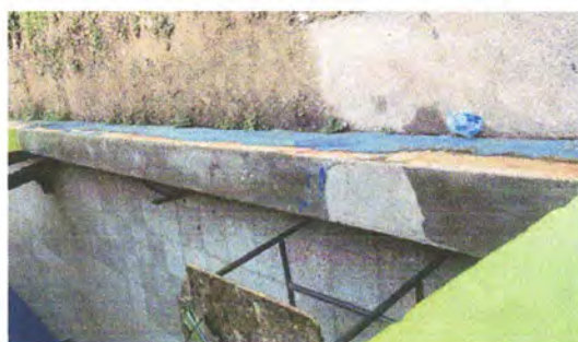
Foto 4: Sustitución de pretil de corredor de aulas .
