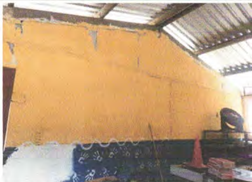
Foto7: Tratamiento de paredes de direccion, interiores
