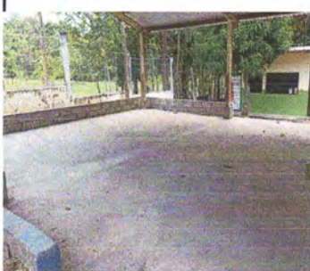
Foto 3: Instalación de cerámica antidéslizante, en el salón de usos multiples.
