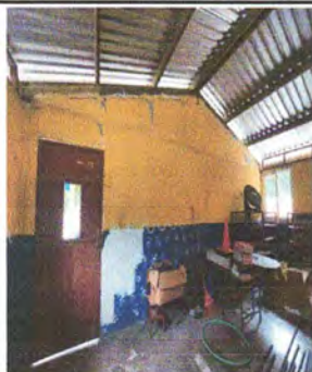
Foto1: Mantenimiento de estructura de metalse 2mts x 1m incluye ( lijado, cepillado, aplicación de pintura, cambio de chapa)
