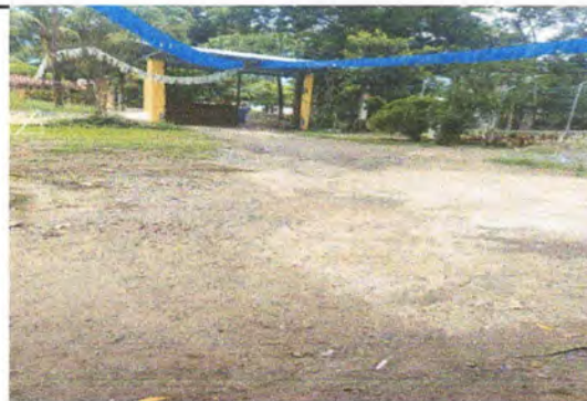
Foto 6: Losa de patio de entrada principal.
