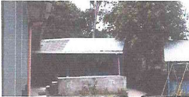
Foto 1: Sustitución de lámina troquelada por lámina troquelada aluzinc calibre 26
