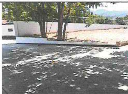
Sustitución, repello y cernido en pared de la entrada, lado izquierdo.
