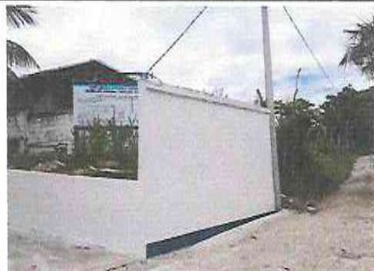
Repello y cernido en paredes, afuera.
