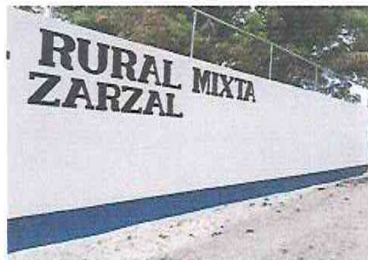
Pintura en muros exteriores, socalo.
