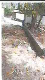
Sustitución y repello en vallado de la entrada, lado izquierdo.
