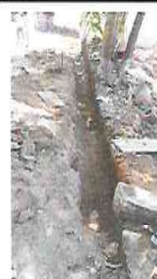
Remoción del vallado en mal estado, lado izquierdo de la entrada.
