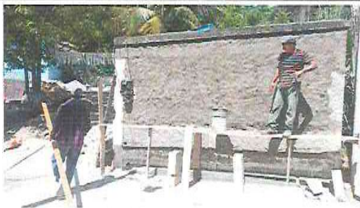
Repello en pared en la parte exterior.
