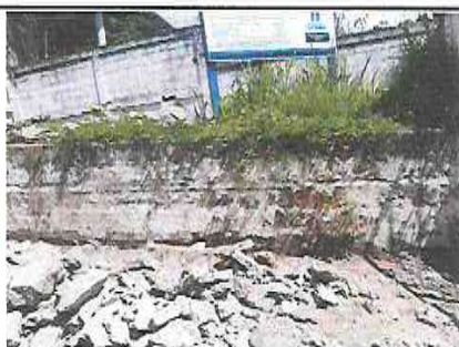
Repello y cernido en pared de la entrada, lado derecho.
