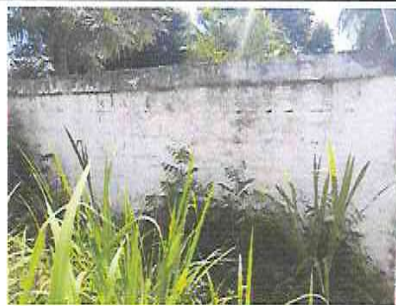
Repello y cernido en paredes, parte interior.
