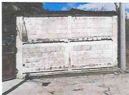
Repello y cernido en paredes, parte exterior.
