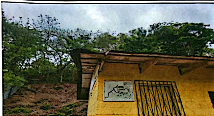
Foto 1: 1.1 SUSTITUCIÓN DE LAMINA POR LAMINA TROQUELADA CALIBRE 26
