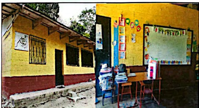
Foto 4: 1.4 PINTURA EN MUROS INTERIORES Y EXTERIORES
