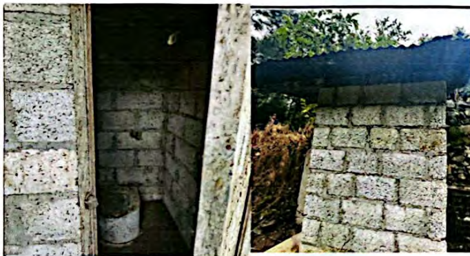
Foto 9: PINTURA EN MUROS INTERIORES Y EXTERIORES
