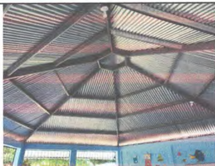
Foto 5: Reparación de Cielo Razo de PVC, Lámparas Led, Ventiladores y Ventanas Marcos de PVC y Vidrio de 5mm. AULA HEXAGONAL.
