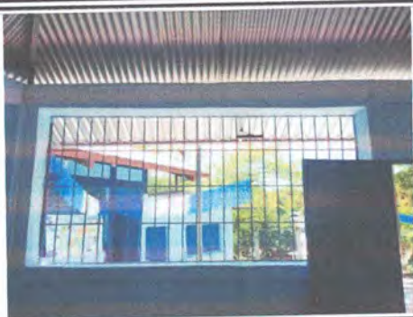
Foto 7: Reparación de Cielo Razo de PVC, Lámparas Led, Ventiladores Y Ventanas Marcos de PVC y Vidrio de 5mm. AULA HEXAGONAL.
