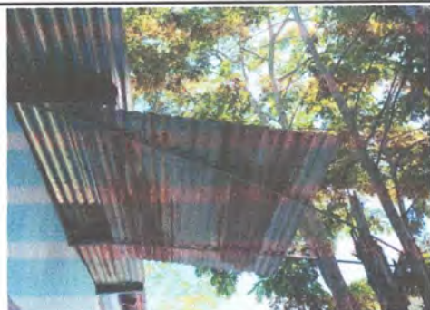
Foto 3: Reparación de Cocina, Polletones, Sustitución de Estructura y Techo de Lamina Troquelada C26 LEGITIMO.
