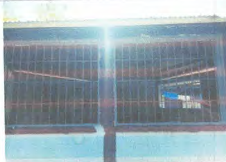
Foto 8: Sustitución de Ventanas Marcos de PVC y Vidrio de 5mm. Y Larguero de Estructura Metalica y Lamina. AULA HEXAGONAL.
