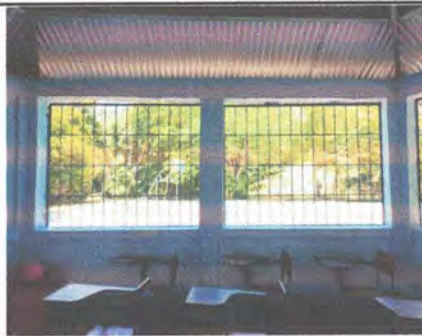
Foto 6: Reparación de Cielo Razo de PVC, Lámparas Led, Ventiladores y Ventanas Marcos de PVC y Vidrio de 5mm. AULA HEXAGONAL.
