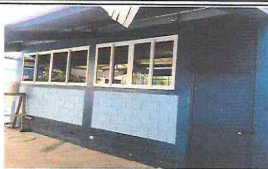
Foto 8: Sustrucción de estructura de soporte de metal y vidrio por ventanas corredizas con material de PVC
