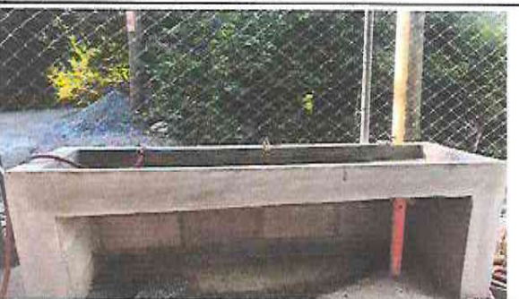
Foto 11: Instalación de lavamanos de concreto con tubería galvanizada mas 3 chorros galvanizados
