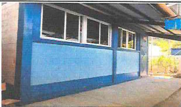
Foto 7: Sustrucción de estructura de soporte de metal y vidrio por ventanas corredizas con material de PVC
