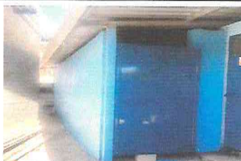
Foto 14: Mantenimiento a bodega (Sustitución de puerta de madera por puerta de metal)
