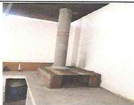
Foto 5: Sustitución de estufa rural completa (Polletón, plancha de metal y chimenea)
