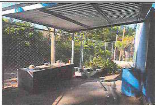
Foto 1: Instalación de lavamanos de concreto con tubería galvanizada mas 3 chorros galvanizados
