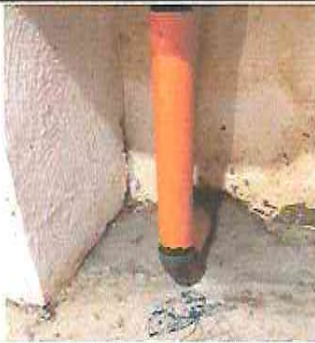
Foto 21: Sustitución de tubería PVC línea principal de aguas negras
