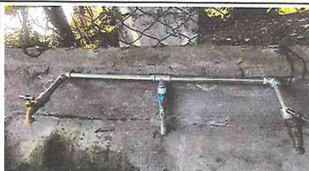
Foto 16: Sustitución de llaves de chorro
