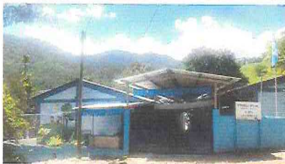
Foto 13: Sustitución de muro perimetral de malla galvanizada, con tubo galvanizado y block
