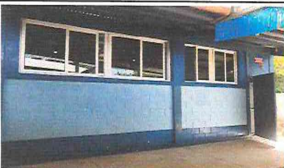
Foto 9: Pintura en muros interiores y exteriores
