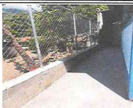
Foto 2: Construcción de banqueta de concreto y muro perimetral de malla galvanizada y block
