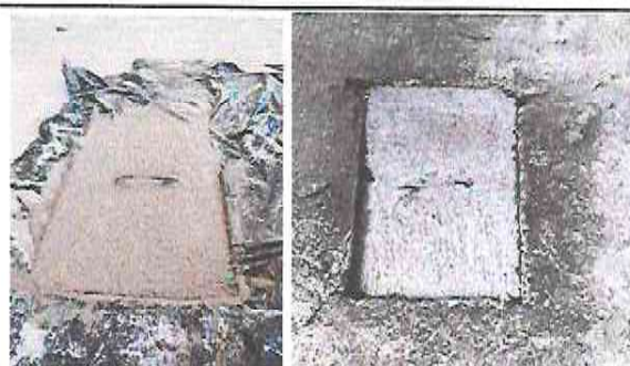
Foto 18: Sustitución de caja de registro
