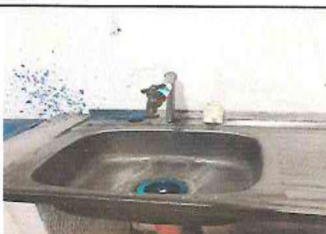
Foto 6: Sustitución de llave de chorro
