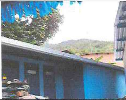
Foto 19: Mantenimiento a bodega (Sustitución de canal plástico)
