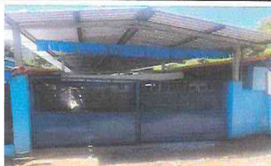
Foto 12: Mantenimiento a portón de metal (Lijado, cepillado, estructura metálica y pintura)
