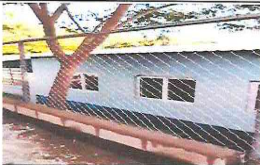
Foto 17: Sustitución de muro perimetral de malla galvanizada, con tubo galvanizado y block
