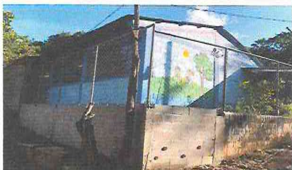
Foto 3: Sustitución de muro perimetral de malla galvanizada, con tubo galvanizado y block
