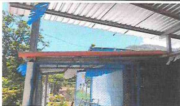
Foto 15: Sustitución de canal plástico
