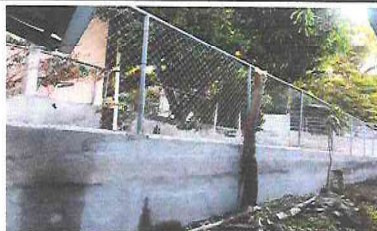
Foto 10: Sustrucción de muro perimetral de malla galvanizada, con tubo galvanizado y block
